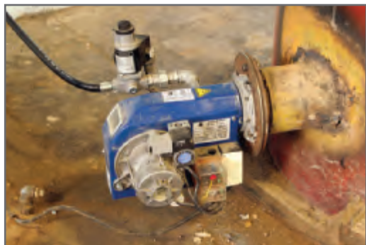
شکل ۱۱- دستگاه دمنده
