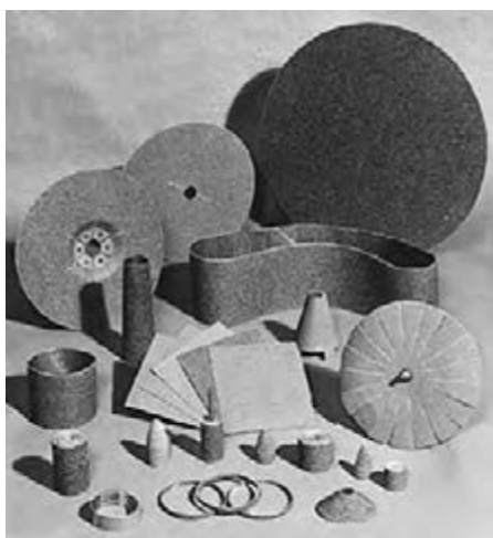
شکل ۲۳- ترکیب نوار برای ساینده‌های پوشش داده شده (بالا). آسیاب صفحه‌ای (سمت راست) و نمونه‌هایی از تسمه و دیسک برای ماشین‌کاری ساینده
