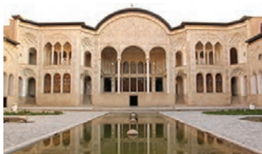
شکل ۳- خانه طباطبایی‌ها (کاشان)
