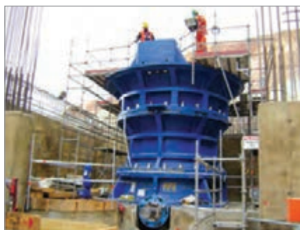
شکل ۱۰- دستگاه سنگ شکن ژیراتوری در حال نصب بر روی فونداسیون
