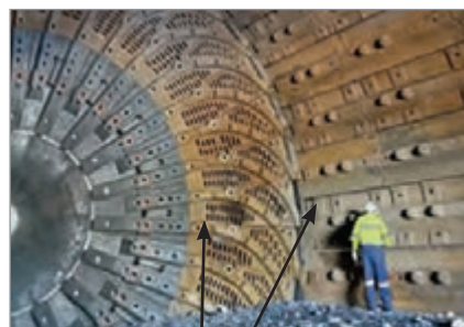
آسترهای دیواره داخل آسیا
