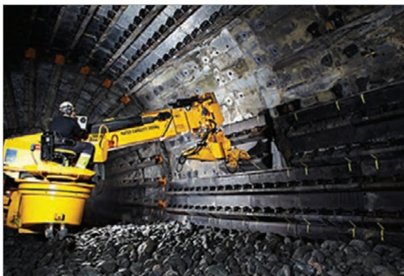
شکل ۱۲- نحوه تعویض آسترهای دستگاه آسیا
