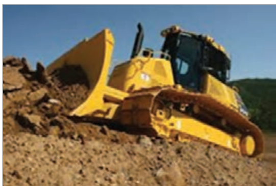
شکل ۲۶- دستگاه بولدوزر در حال جابه‌جایی خاک و هموار کردن مسیر حمل و نقل
