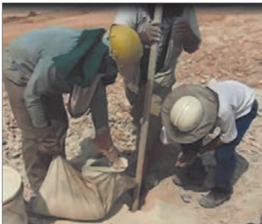
شکل ۳۳- ریختن مواد منفجره (آنفو) درون چال و کوبیدن به وسیله سنبه چوبی
