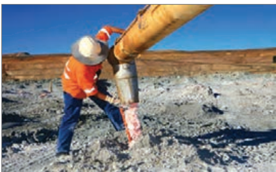
شکل ۱۶- عملیات انتقال مواد منفجره ژله ای به داخل چال
