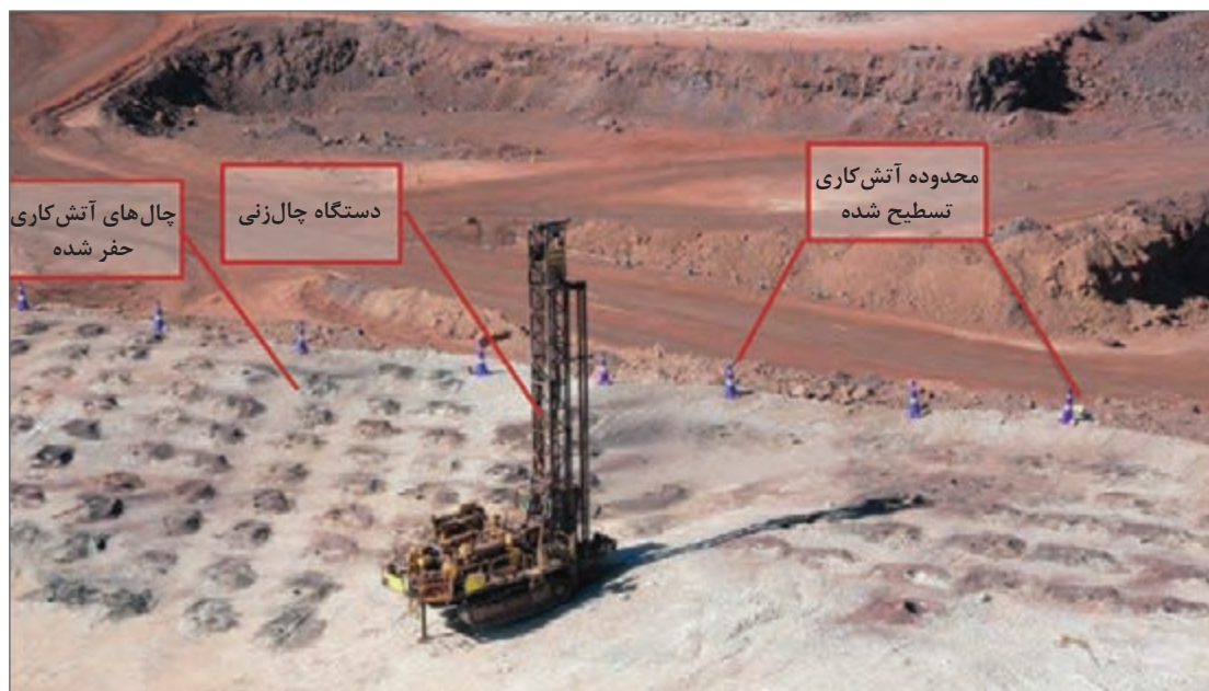
شکل ۱۲- دستگاه حفاری DTH در حال حفر چال‌های انفجاری
