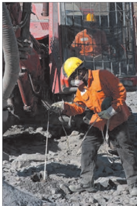
شکل ۱- اندازه‌گیری عمق چال حفاری شده به وسیله متر وزنه‌دار
