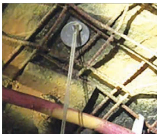
شکل ۱۴- ایستگاه نقشه برداری در سقف تونل معدن زیرزمینی
