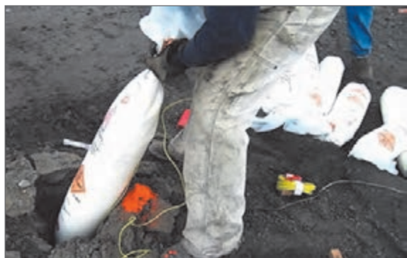
شکل ۲۲- مواد منفجره درون کیسه های پلاستیکی پارافین دار
