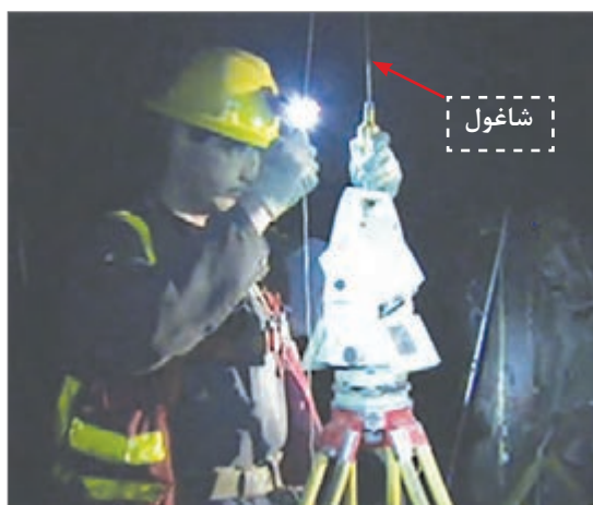
شکل ۱۵- نصب محل دوربین نقشه برداری با شاغول در تونل
