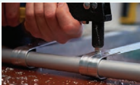
شکل ۲۱- اتصال لوله به پروفیل با پرچ میخی
