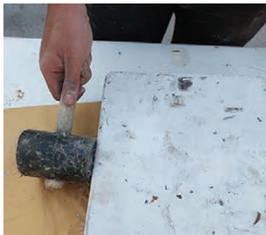
شکل ۱۴- برگرداندن قالب و ضربه زدن آرام برای بیرون آمدن خشت گلی از قالب
