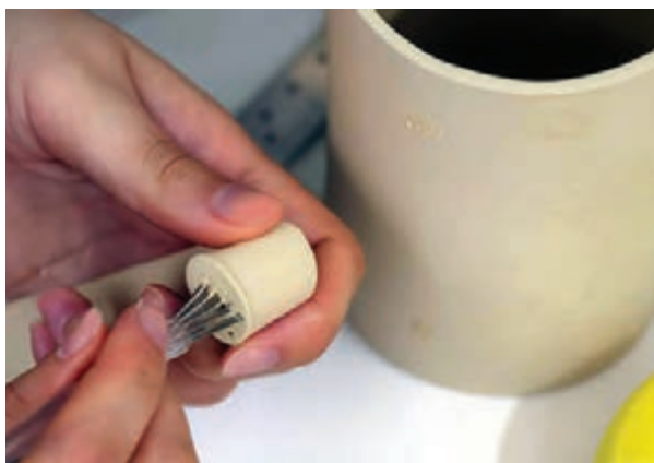
شکل ۹- خراش دادن محل اتصال
