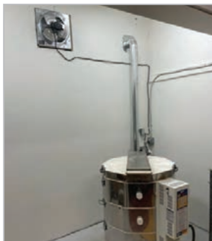
شکل ۲۲- تهویه درست و استاندارد کوره و کابین لعاب
