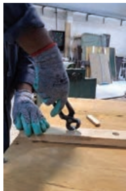
شکل ۸- خارج کردن میخ از چوب با گاز انبر
