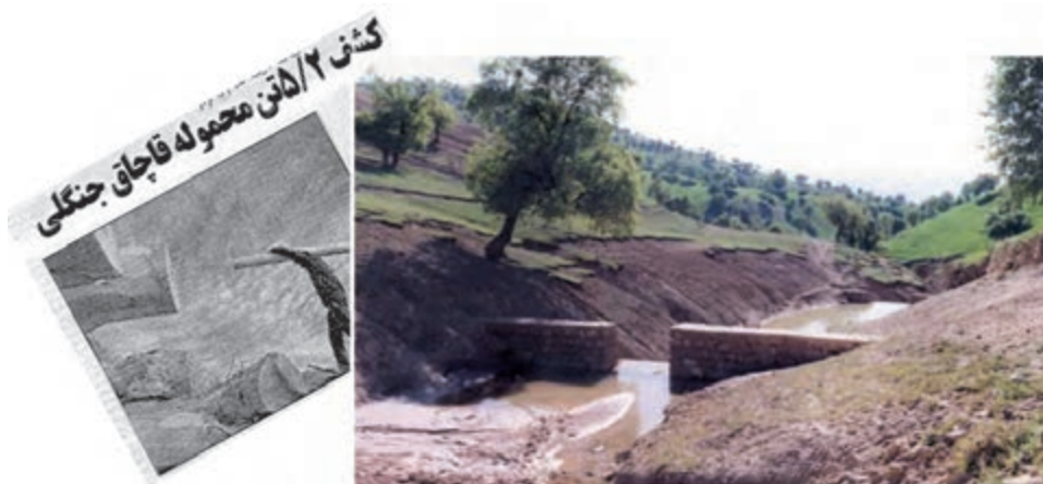
تصویر ۴-۱۵- اجرای طرح‌های آب‌خیزداری جهت کنترل سیلاب
