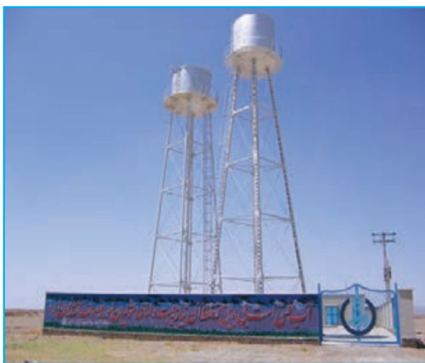
شکل ۱۰-۱۴- اجرای طرح آبرسانی بهداشتی روستایی
