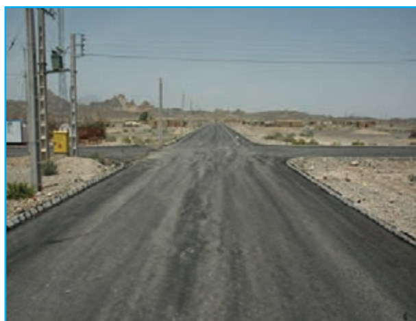
شکل ۹-۱۴- اجرای طرح‌های روستای چگرد خاش
