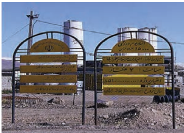
شکل ۱۰-۶- ورزشگاه ۱۵۰۰۰ نفری قزوین در حال ساخت
