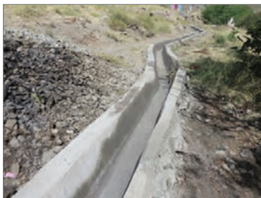
شکل ۲۵- انتقال آب از منبع تا مزرعه از طریق کانال‌های بتنی یا لوله پلی‌اتیلن، نقش عمده‌ای در پیشگیری از رشد گیاهان ناخواسته دارد.
