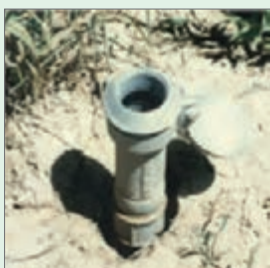
شکل ۴۸- محل شیر فلکه روی بال
