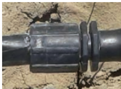
شکل ۸۱- نصب نوار تیپ روی لوله
