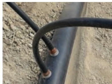
شکل ۷۹- اتصال لوله ۱۶ به لوله فرعی
