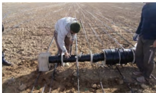
شکل ۷۰- پهن کردن دستی نوار تیپ
