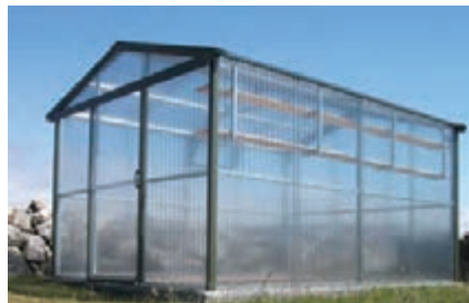
شکل ۲۸- گلخانه با پوشش پلی‌کربنات و صفحه‌های پلی‌کربنات
