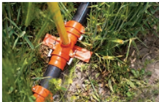
شکل ۳۹- نصب رایزر آبپاش با استفاده از اتصالات نیوفیت
