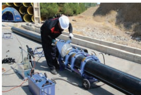
شکل ۳۵- اتصال لوله‌های پلی‌اتیلن به روش جوشکاری
