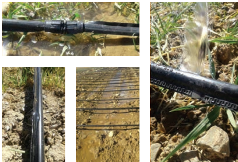
شکل ۸۵- نشستی آب به دلیل عدم رعایت مسائلی نظیر کیفیت لوله تیپ و اتصالات، تسطیح بستر و جهت قرارگیری قطره چکان‌های تیپ بر روی خاک
