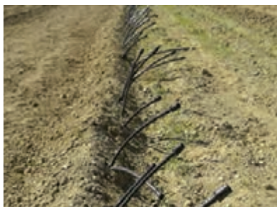
شکل ۸۰- خروج لوله های ۱۶ از زیر خاک
