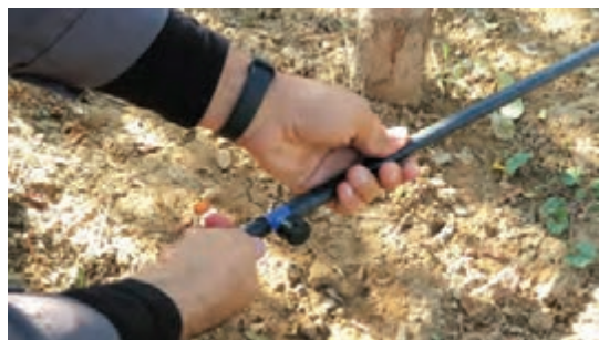
شکل ۸۳- نحوه نصب سه راهی قطره چکان دار
