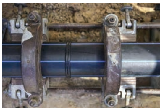
شکل ۳۵- اتصال لوله‌های پلی‌اتیلن به روش جوشکاری
