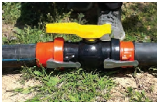
شکل ۳۸- نصب شیر با استفاده از اتصالات نیوفیت
