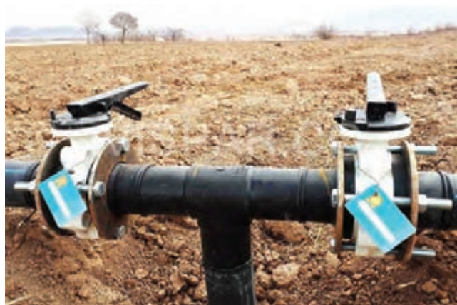
شکل ۲۸- نصب شیر پروانه‌ای با استفاده از فلنج
