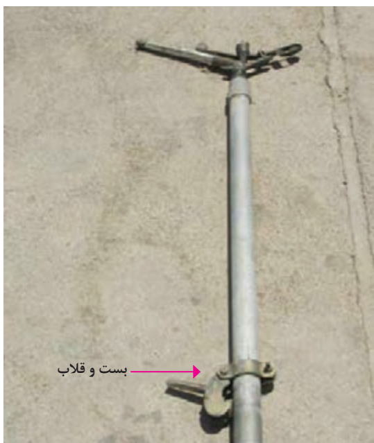
شکل ۴۵- بست و قلاب بسته شده روی رایزر که ممکن است از محل خود حرکت کند
