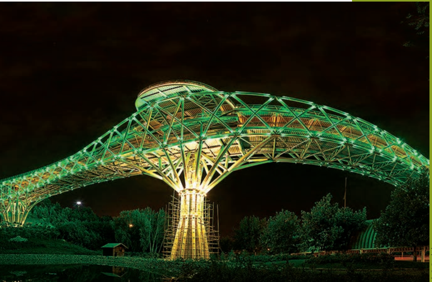
پل طبیعت تهران
