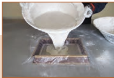
ث - ریختن ملات گچ در قالب
