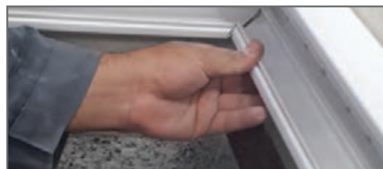
شکل ۵۹- برش و فارسی بر کردن ترانکینگ
