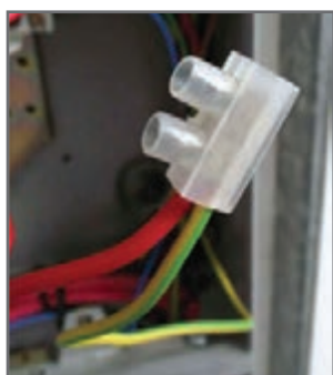
شکل ۱۳- اتصال هادی فاز و حفاظتی
