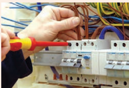
شکل ۴۸- محکم کردن سیم‌ها در محل اتصال به قطعه
