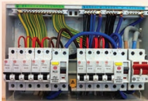
شکل ۴۹- اتمام سیم‌کشی قطعات تابلو
