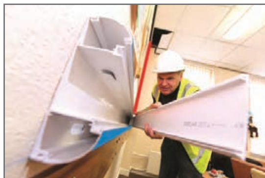
شکل ۵۰- نصب درپوش ترانکینگ
