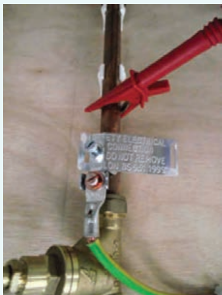
شکل ۱۰- اتصال فیش گیره‌دار به سیم همبندی
