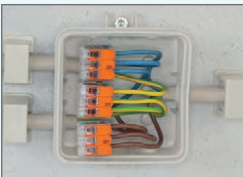
شکل ۳۹- کاربرد ترمینال فشاری ۳ تایی
