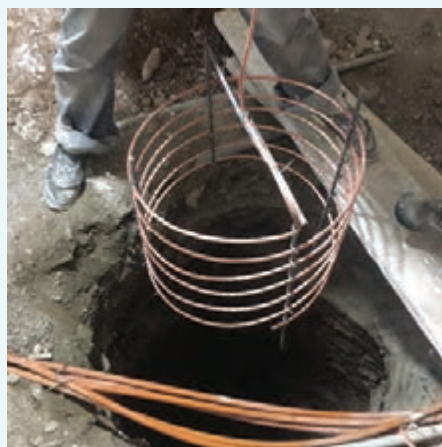
شکل ۴- هادی اتصال به زمین
