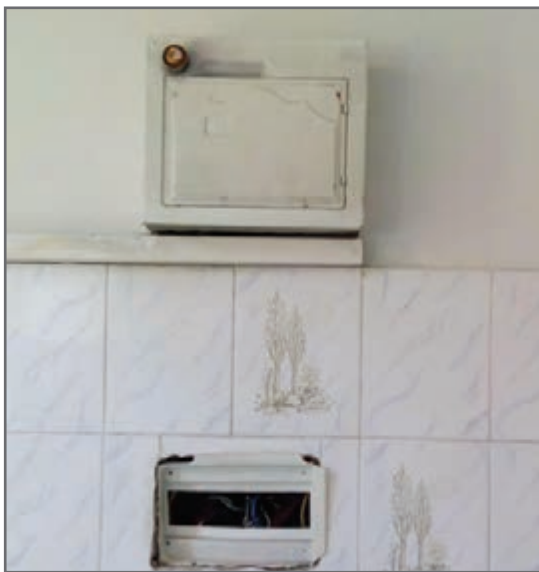
شکل ۲- تعویض تابلو فیوز روکار با نوع آسیب‌دیده توکار
