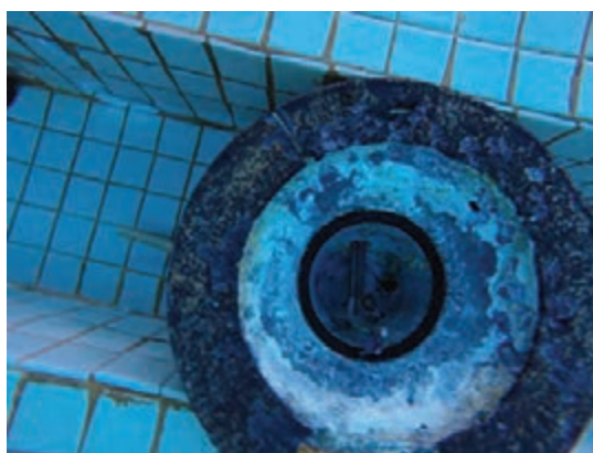
شکل ۴- روشنایی استخر معیوب است و رفع عیب آن باید با رعایت نکات حفاظتی و ایمنی باشد.
