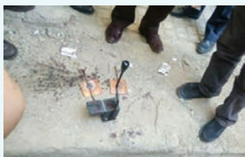
شکل ۳- رعایت فاصله از بوته مخصوص جوش اگزوترمیک
