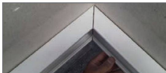
شکل ۵۹- برش و فارسی بر کردن ترانکینگ
