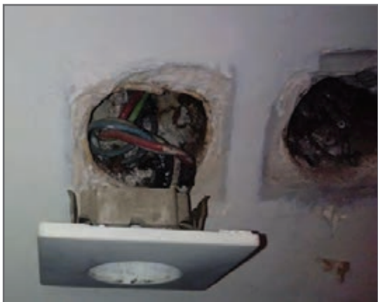
شکل ۳- قاب جداشده پریز از دیوار
