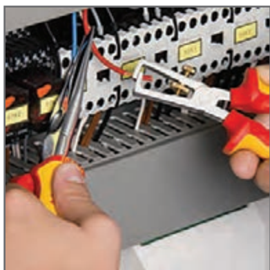
شکل ۹- روکش برداری با سیم لخت کن دستی
