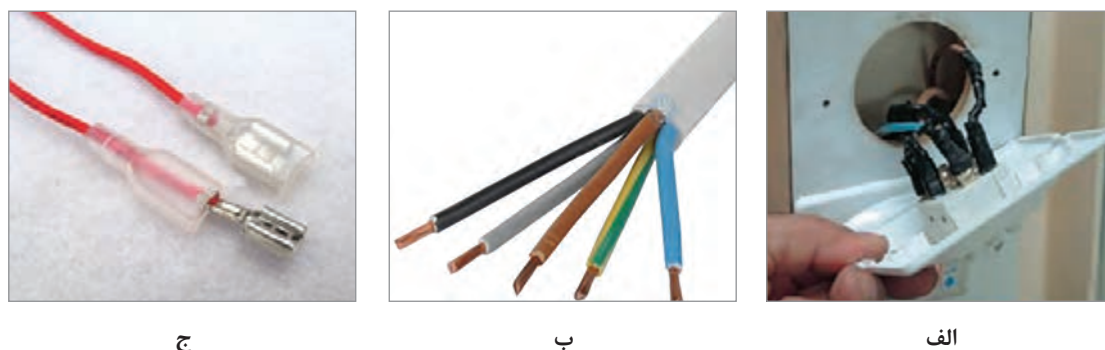
شکل ۵- اتصالات کلید کولر آبی
