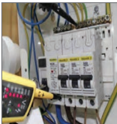
شکل ۵- ولتاژ خط فاز و هادی حفاظتی
