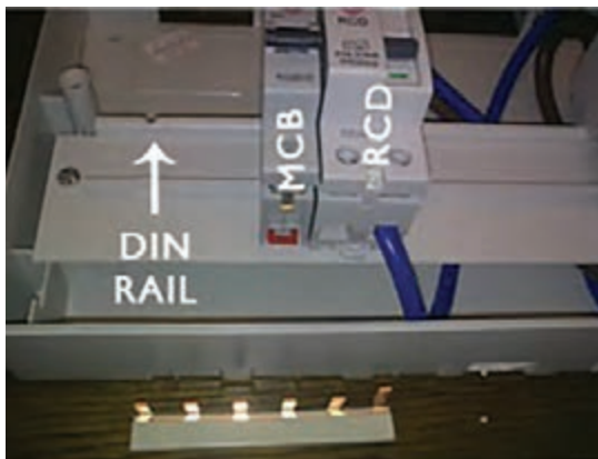
ب) قبل از نصب شین
