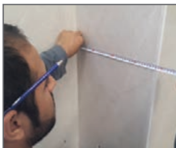
شکل ۵۵- تراز کردن ترانکینگ
