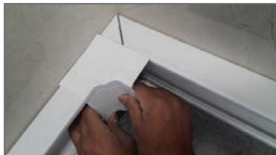
شکل ۶۰- نصب زانوی داخلی
