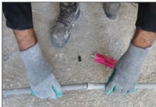
شکل ۴۰- اتصال لوله PVC
