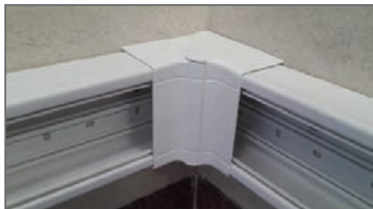
شکل ۶۰- نصب زانوی داخلی
