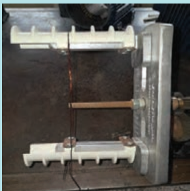
شکل ۳۱- تنظیم کلاف پیچ
