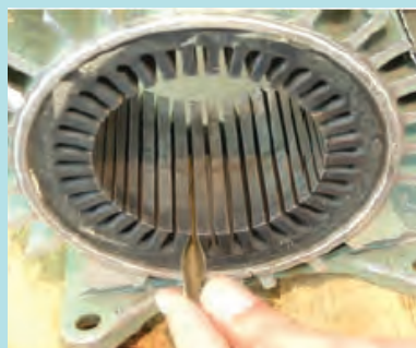
شکل ۲۹- قرار دادن عایق آماده شده داخل شیار
