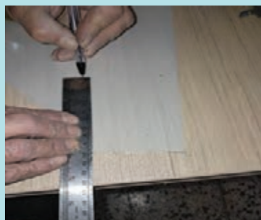
شکل ۲۶- اندازه‌گیری و برش عایق موجود در کارگاه
