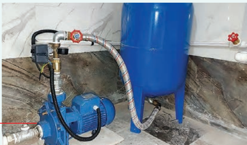
شیر هواگیری
