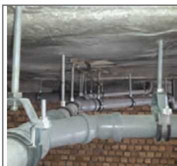
شکل ۱۳- نمونه اجرایی زیر سقف
