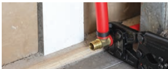
شکل ۳۱- اتصال فشاری با پرس و بدون پرس
