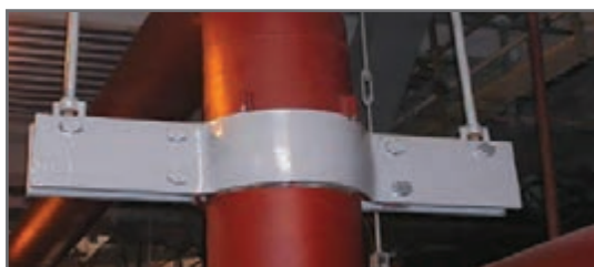
شکل ۹- تکیه گاه لوله قائم
