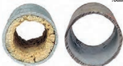
شکل ۳- مقایسه دو لوله کار کرده در دو حالت آب سختی گیری شده و سختی گیری نشده
