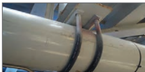
شکل ۸- تکیه گاه لوله افقی
