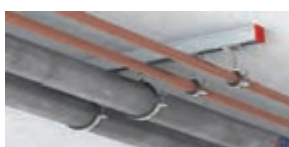
شکل ۱۰- نمونه‌ای از اجرای تکیه‌گاه
