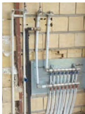
شکل ۴۷- آزمایش سیستم لوله‌کشی
