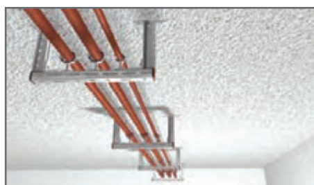
شکل ۱۷- نمونه اجرایی زیر سقف
