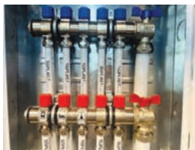
شکل ۳۸- کلکتور انشعابی سرد و گرم
