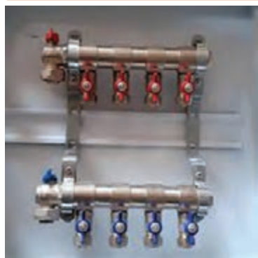
شکل ۴۲- کلکتور سرد و گرم
