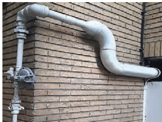
شکل ۱۲- نقطه شروع لوله کشی گاز
