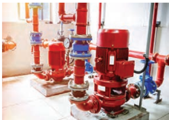
شکل ۴۶- پمپ‌خانه سیستم آتش‌نشانی
