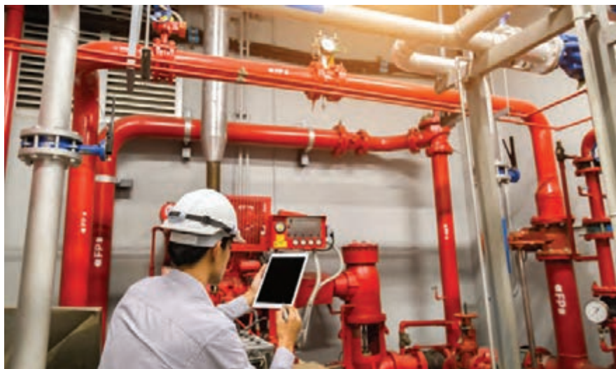
شکل ۵۶- بازرسی سیستم اطفای حریق
