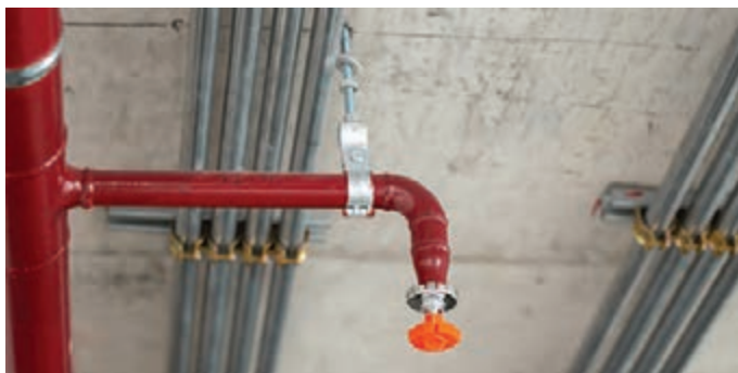
شکل ۱۳- نمونه لوله و اتصالات جوشی اسپرینکلر
