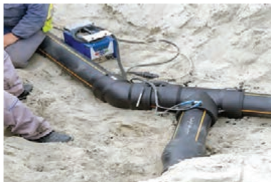
شکل ۶- جوشکاری لوله و اتصال پلی اتیلن به روش الکتروفیوژن
