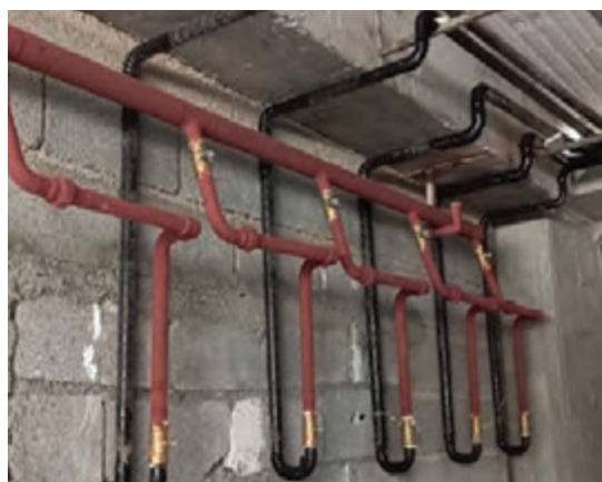
کلکتور با لوله کشی گاز توکار
