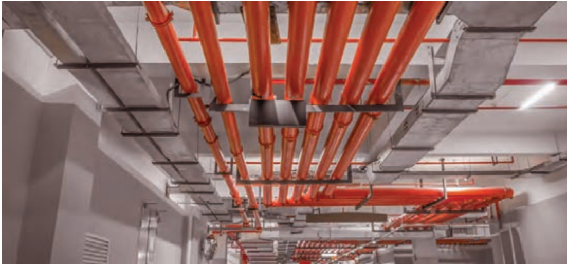
شکل ۲- نمونه لوله کشی آتش نشانی ساختمان
