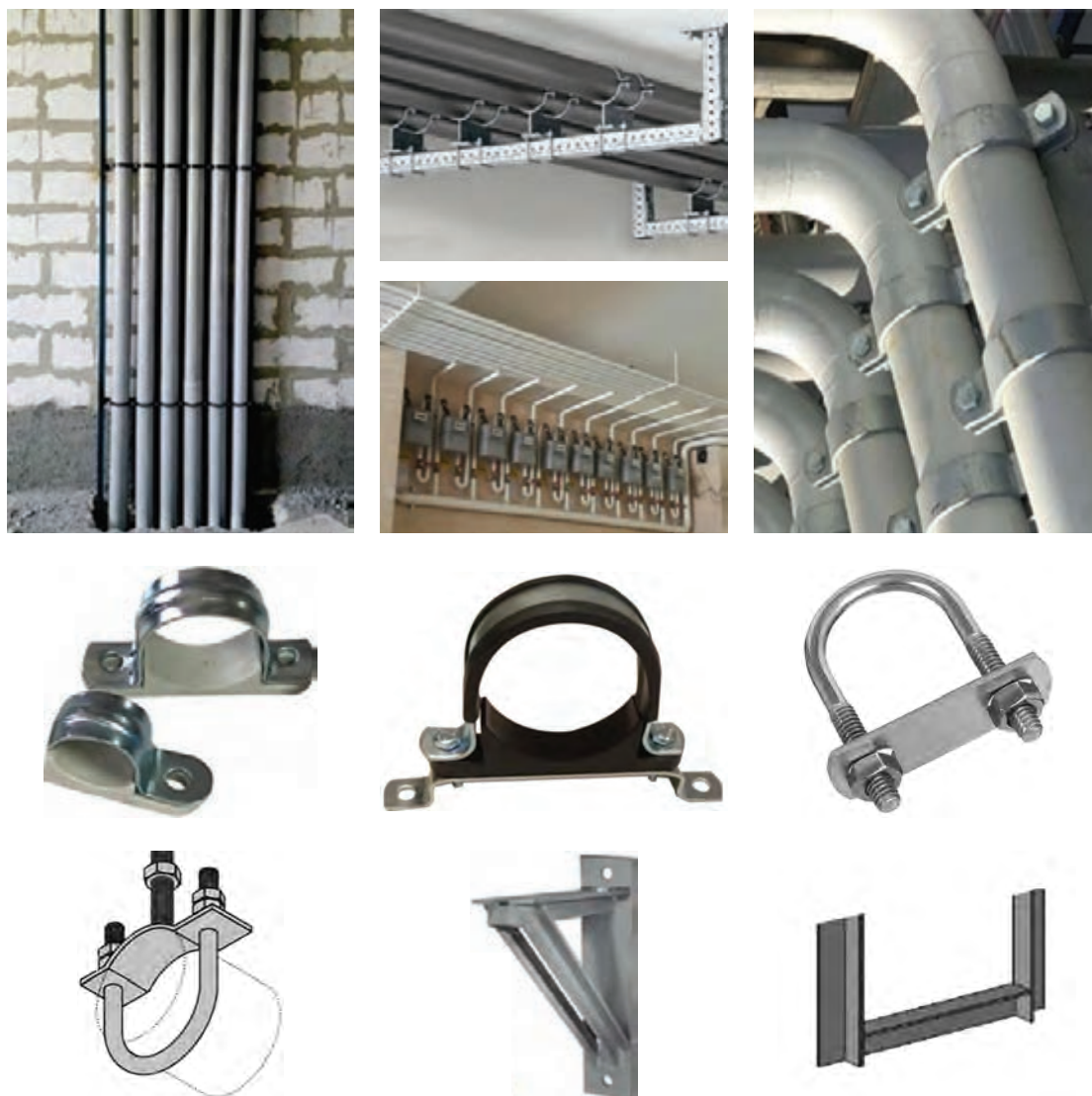
شکل ۵۵- ساپورت‌های مورد استفاده در لوله‌کشی
