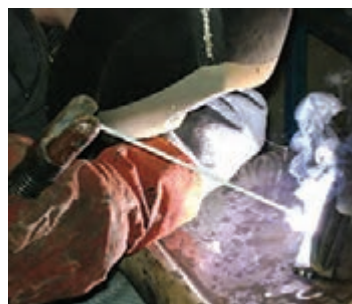
جوش کاری برق
