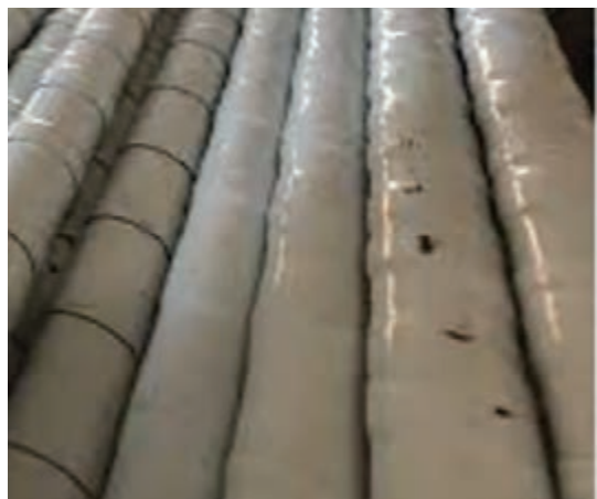
شکل ۴۲- عایق‌کاری لوله‌های توکار
