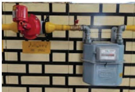
شکل ۱۳- شیر خودکار قطع گاز حساس در مقابل زلزله
