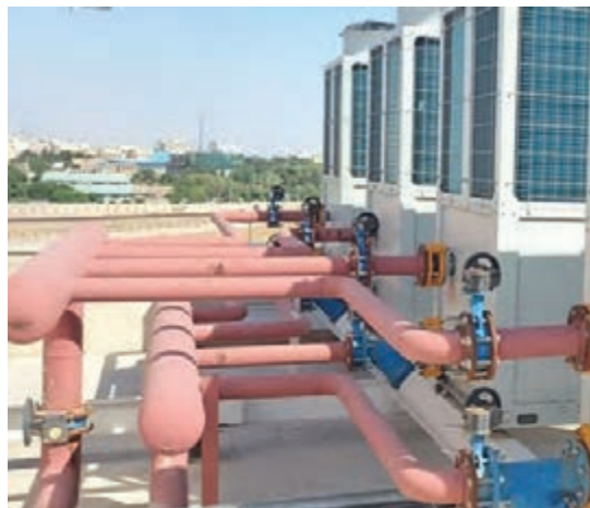
شکل ۴۳- دو نوع کلکتور آب
