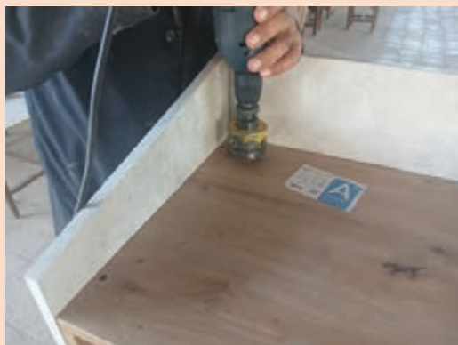
شکل ۲۸- سوراخ‌کاری با مته گردبر ۶۰ میلی‌متر
