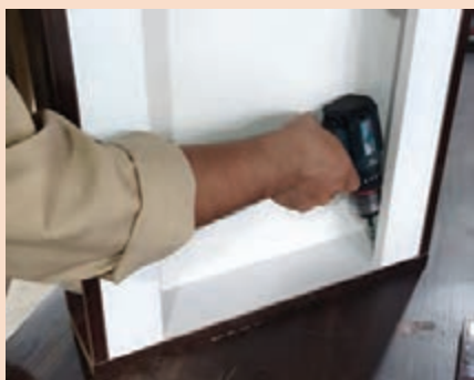
شکل ۹۰- نصب قید ریل روی بدنه جعبه
