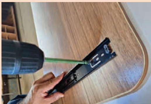
ب) نصب قسمت ثابت ریل
