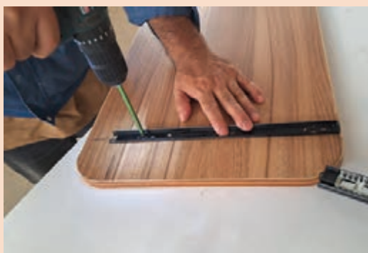
د) نصب قسمت متحرک ریل
