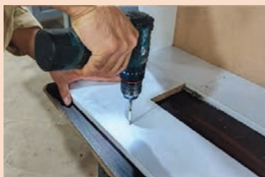
شکل ۲۱- سوراخ کاری محل پین روی وادار
