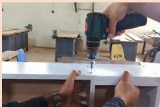
شکل ۲۲- سوراخ کاری محل پیچ وادار
