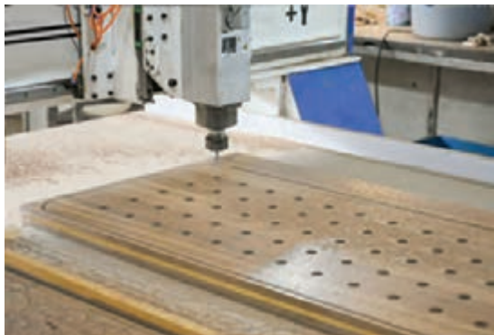
(ب) اجرای سوراخ کاری طبقات و دوربری قطعات
