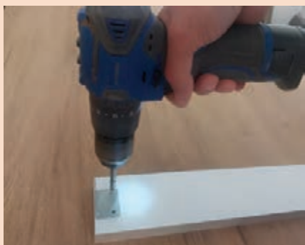
شکل ۸۸- نصب نبشی اتصال با پیچ
