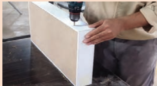
شکل ۲۴- سوراخ‌کاری محل نصب کش
