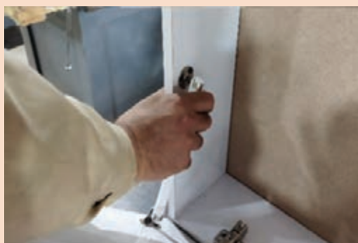
شکل ۴۰- جا انداختن قسمت بالای جک روی پایه
