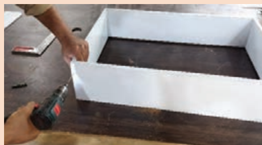
شکل ۱۹- سوراخ کاری گوشه آخر
