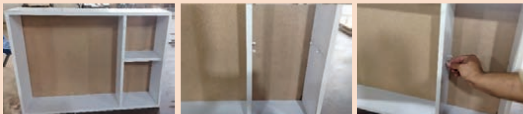
شکل ۲۵- قرار دادن پین‌های طبقه و نصب آن
