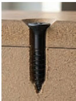
مقطع برش خورده از نحوه استقرار پیچ در بخش خزینه کاری شده
