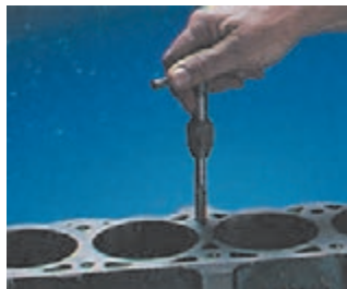
تمیز کردن و بررسی رزوه‌ها
