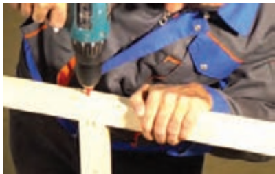
شکل ۴۷- بستن پیچ
