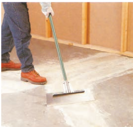
شکل ۲۹- پوشاندن شکاف ها
