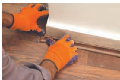
شکل ۸۷- نصب لمینت در آستانه در
