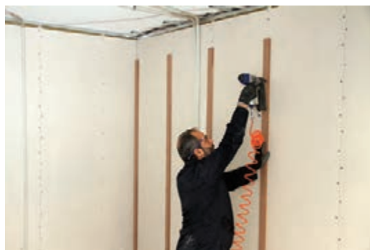
شکل ۱۰۳- نصب قطعات زیرسازی براساس نقشه
