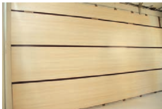
شکل ۱۳۹- ردیف آخر به صورت کامل
