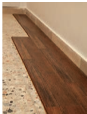
شکل ۶۲- نصب ردیف اول و دوم کف پوش لمینت بر روی موزاییک
