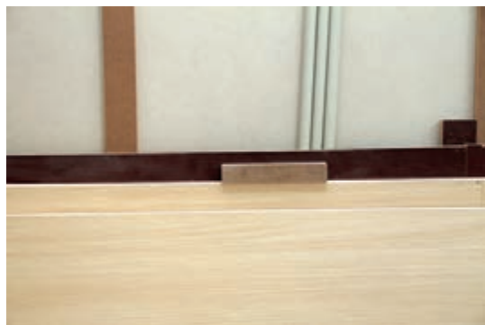
شکل ۱۲۵- قرار دادن فاصله انداز
