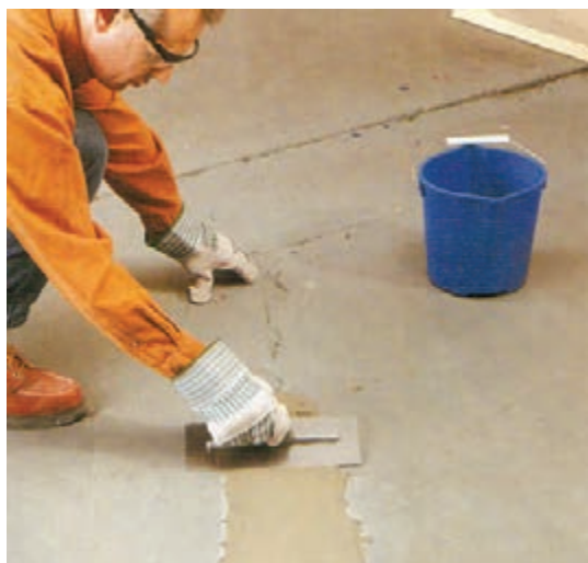
شکل ۲۸- هموار کردن سطح
