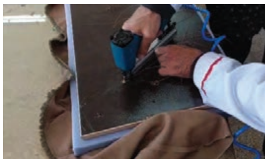
شکل ۷۰- کشیدن نخ‌ها و منگنه کردن آنها در زیر
