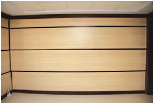
شکل ۱۴۳- اجرای قرنیز کف و زیر سقف به طور کامل
