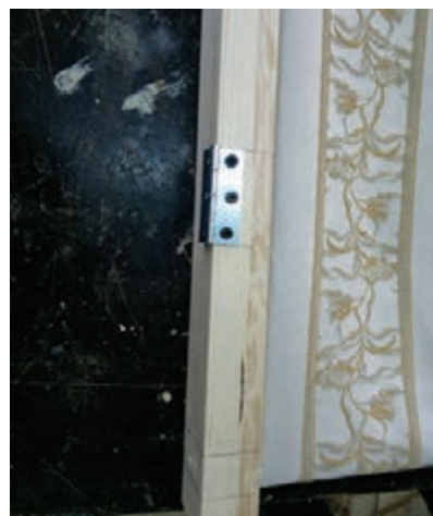
شکل ۵۴- محکم کردن برگه اول لولا با ۳ پیچ
