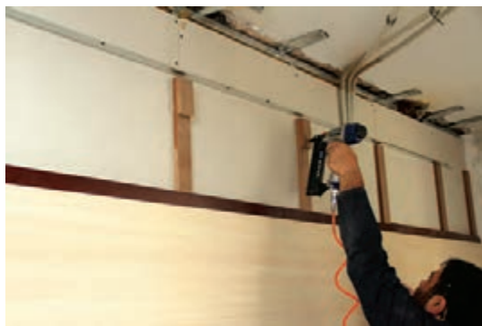
شکل ۱۳۳- نصب قطعات برای یکسان سازی
