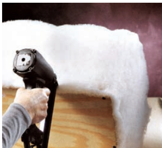
شکل ۹۲- نصب اسفنج به بدنه صندوقچه
