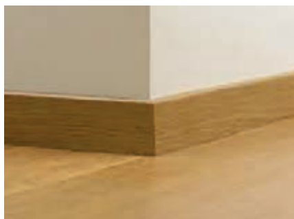
شکل ۷۹- اتصال قرنیز در کنج به صورت فارسی
