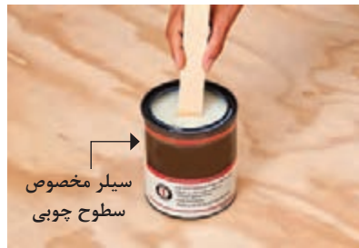
شکل ۱۰۵- یکنواخت کردن محتویات قوطی
