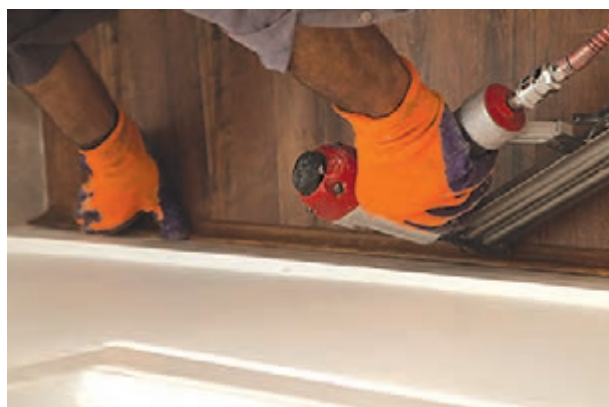
شکل ۸۸- مراحل نصب و میخ زدن قرنیز و پوشش نهایی کف پوش
