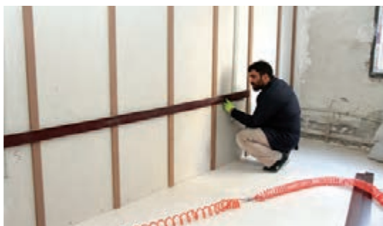
شکل ۱۱۰- تنظیم قطعه درز
