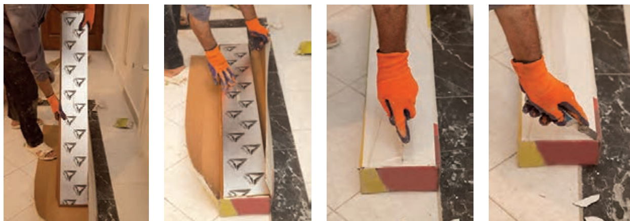
شکل ۴۱- مراحل باز کردن جعبه های لمینت
