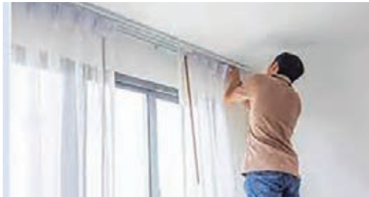
شکل ۱۱۲- نصب پرده ها
