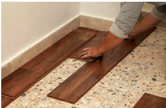
شکل ۶۲- نصب ردیف اول و دوم کف پوش لمینت بر روی موزاییک
