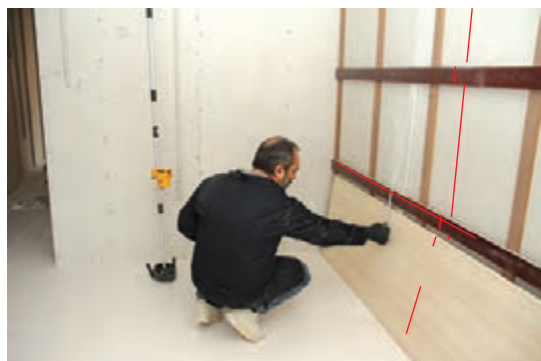
شکل ۱۱۷- اندازه گیری با متر از بالا
