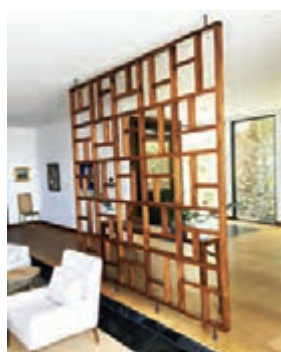
شکل ۱۸- اتصال به کف و سقف
