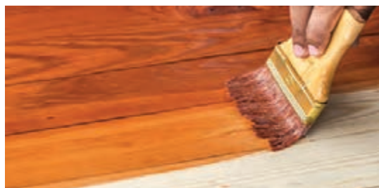
شکل ۵۳- آستری زدن با قلم مو
