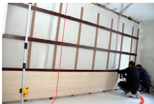
شکل ۱۲۴- نصب قطعه آخر ردیف اول
