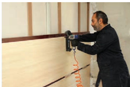
شکل ۱۲۹- ادامه میخ کوبی و نصب ردیف دوم
