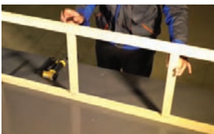
شکل ۴۴- اتصال موقت قطعات پاراوان با منگنه
