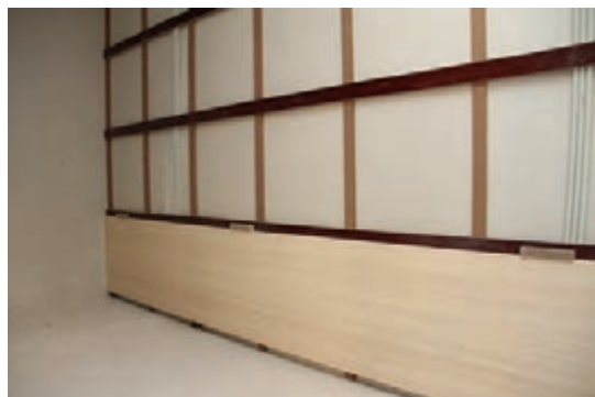
شکل ۱۲۶- فاصله ۱/۵ متری بین دو فاصله انداز
