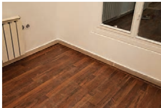
شکل ۸۱- پروفیل اسکوتیا (یک نوع نوار لبه) و استفاده از آن برای اتصال کف پوش لمینت به قرنیز سنگی دیوار
