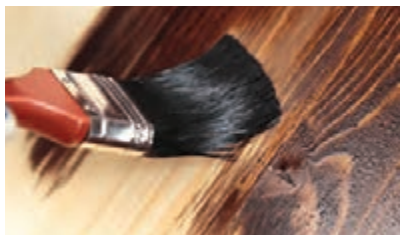
شکل ۵۹- زدن آستری با قلم‌مو
