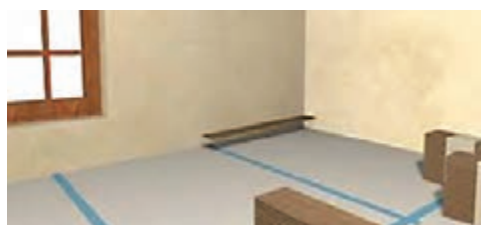
شکل ۴۰- پوشش کامل کف با فوم صدا گیر
