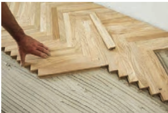
شکل ۱۸- نصب پارکت چوبی با چسب
