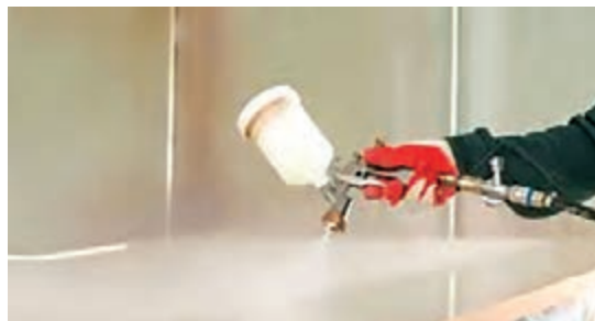
شکل ۸- پاشیدن بتونه با پیستوله
