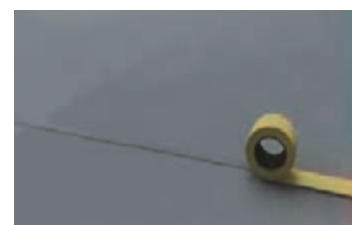
شکل ۳۸- از نوارچسب پهن در محل هم‌پوشانی لبه‌های فوم
