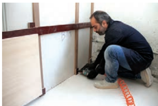
شکل ۱۲۱- نصب قطعه برای قطعه دوم ردیف اول
