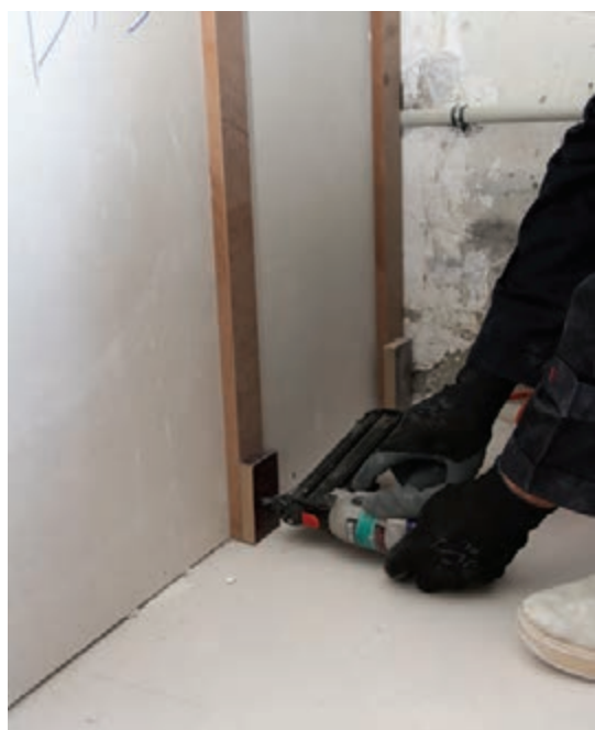
شکل ۱۱۸- نصب قطعه کمکی برای ردیف اول
