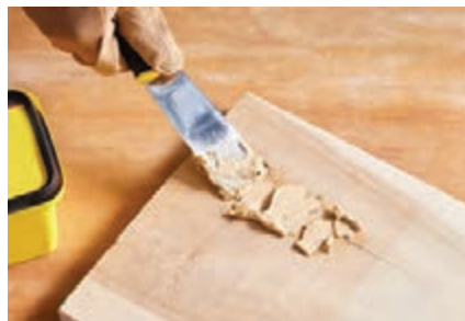
شکل ۳۷- پرکردن ترک با بتونه
