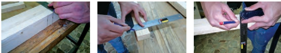
شکل ۳۸- خط‌کشی و انتقال اندازه‌ها به ضخامت چوب
