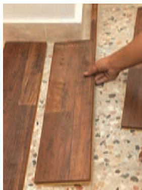
شکل ۸۶- قفل کردن قطعات لمینت به یکدیگر
