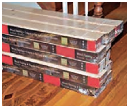
شکل ۲۶- تخلیه کف پوش لمینت در محل نصب
