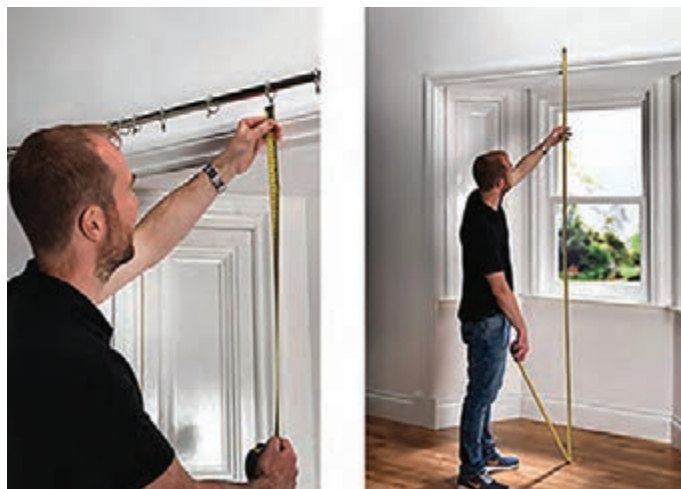
شکل ۹۹- اندازه‌گیری محل نصب پرده
