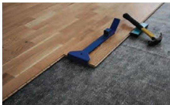
شکل ۳۷- نصب کف پوش لمینت روی موکت
