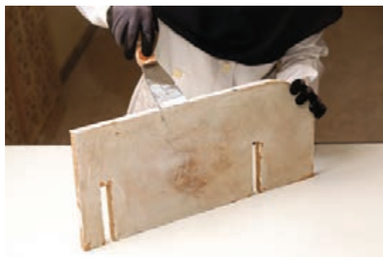
شکل ۱۸۸- بتونه کاری لبه قطعات
