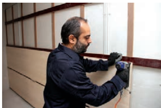
شکل ۱۲۸- نصب ردیف دوم
