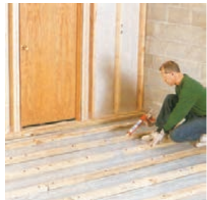
شکل ۱۲- اتصال قطعات زیرسازی به کف
