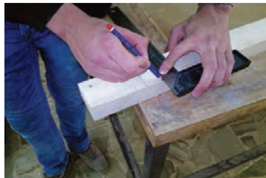
شکل ۳۴- اندازه‌گیری و خط‌کشی محل نصب قید پایین پاراوان
