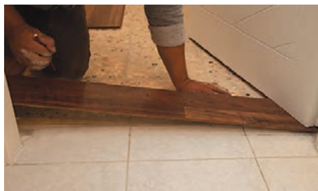
شکل ۸۶- قفل کردن قطعات لمینت به یکدیگر
