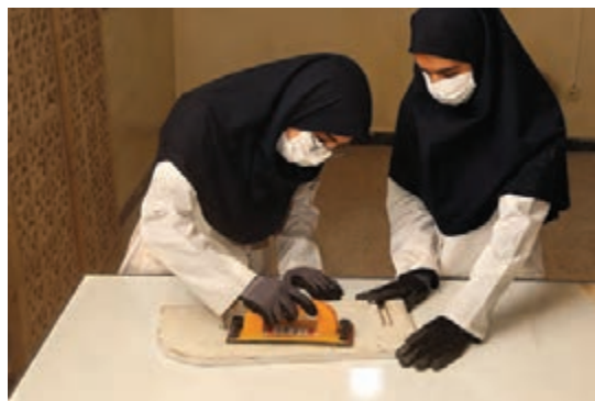
شکل ۱۸۹- سنباده‌کاری سطح بتونه شده با سنباده‌گیر
