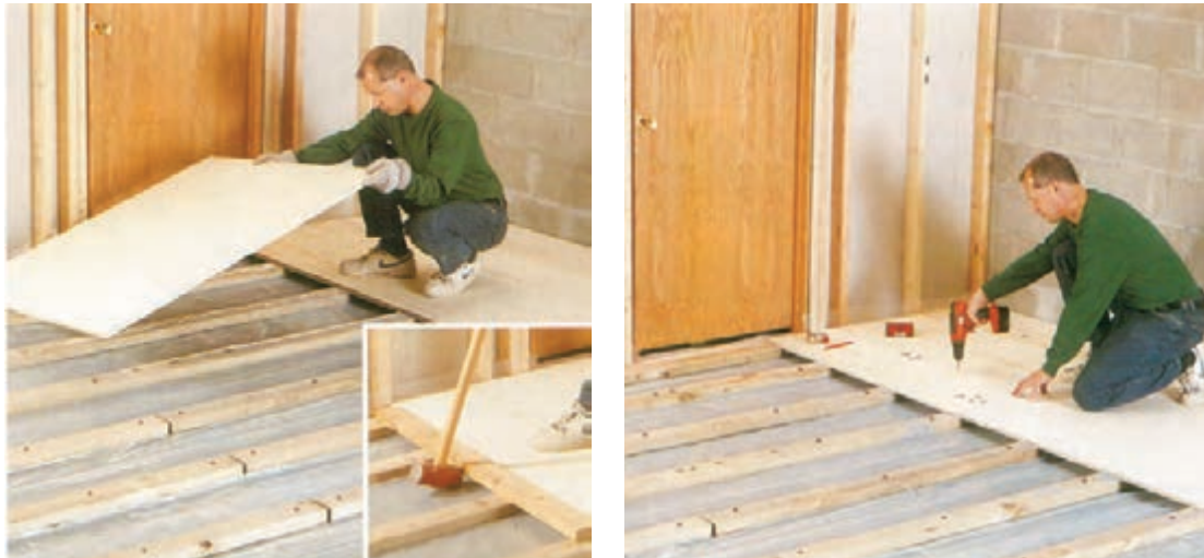
شکل ۲۲- قرار دادن و میخ‌کوبی، تخته چندلایه روی زیرسازی
