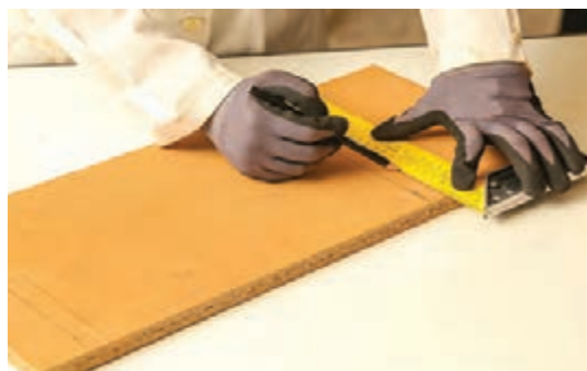
شکل ۱۷۳- ترسیم محل اتصالات با گونیا
