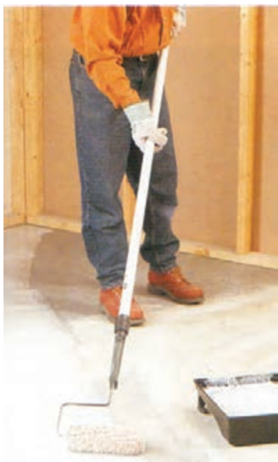
شکل ۳۲- غلتک زدن و تسطیح
