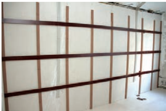
شکل ۱۱۴- نصب تمام قطعات افقی
