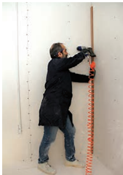
شکل ۱۰۲- نصب قطعات چهارتراش
