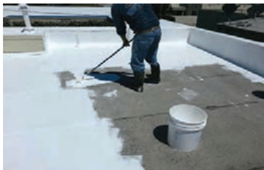
شکل ۵۲- عایق رطوبتی و اجرای آن با غلتک
