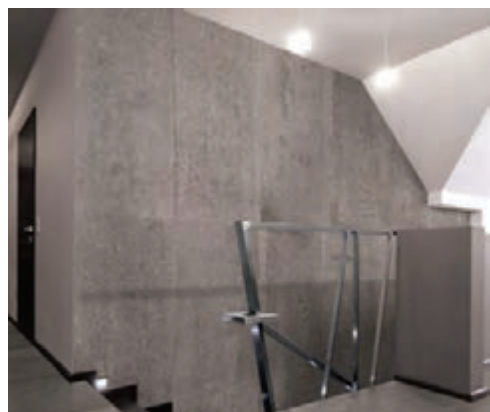
شکل ۲۴- یک جداره داخلی از بتن نمایان قالبی
