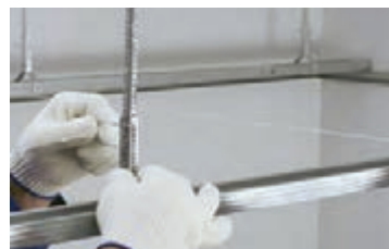
شکل ۴۰- جزییات و اتصالات شاسی سقف های کاذب
