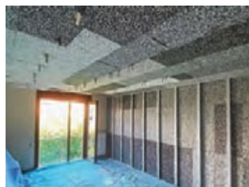
شکل ۵۷- اجرای عایق صوتی ورقه‌ای
