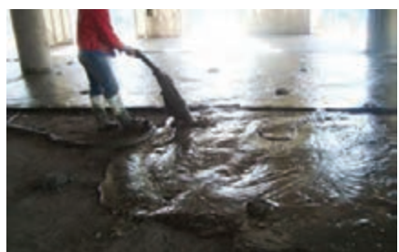
شکل ۷- اجرای فوم بتن به صورت دستی (به رقیق بودن ونحوه شکل گرفتن فوم بتن در فضا دقت کنید)
