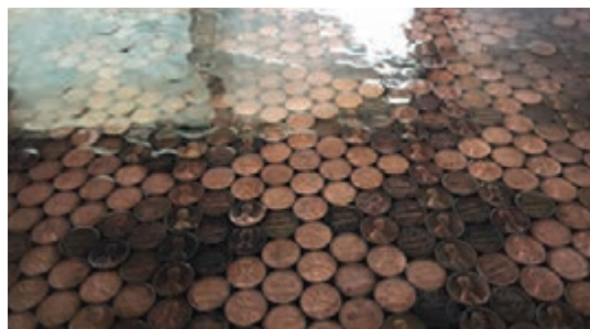
شکل ۱۴- قرار دادن اشیای کوچک مانند سکه زیر اپوکسی
