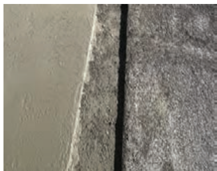
شکل ۶- سطح نهایی اسکرید (نیمه چپ تصویر اسکرید پیش از خشک شدن)
