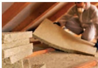
شکل ۵۵- نحوه اجرای عایق‌های حرارتی ورقه‌ای
