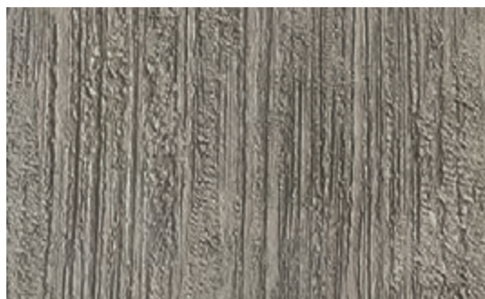
شکل ۲۰- ایجاد بافت با استفاده از میکروسمنت
