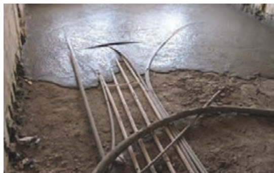
شکل ۱۱- از قابلیت های فوم بتن محافظت از لوله های تأسیساتی و پوشاندن آنها است.
