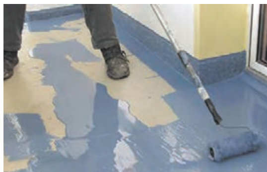
شکل ۱۲- یکی از روش های اجرای اپوکسی
