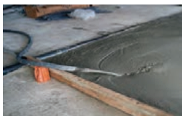
شکل ۸- اجرای فوم بتن به صورت مکانیزه شکل ۹- قالب‌بندی برای اجرای فوم بتن شکل ۱۰- پرداخت سطح فوم بتن جهت اجرای پوشش نهایی
