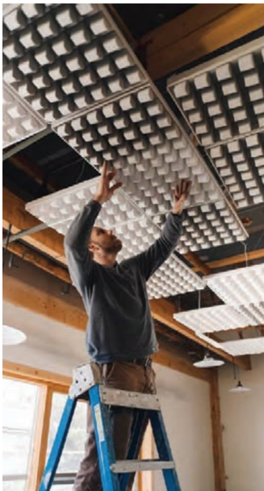
شکل ۱۴- ایجاد پوسته کاذب در زیر سقف اصلی
