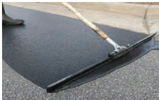
شکل ۵۳- اجرای عایق رطوبتی مایع با تی
