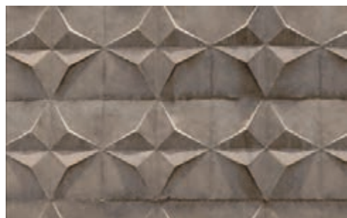
شکل ۲۳- بتن نمایان اجرا شده با قالب طرح دار
