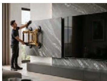
شکل ۳۱- نحوه نصب سنگ اسلب به وسیله قاپک
