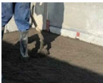
شکل ۴- پخش کردن مخلوط اسکرید روی کف
