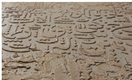
شکل ۲۱- ایجاد بافت منظم نظیر فونت با میکروسمنت
