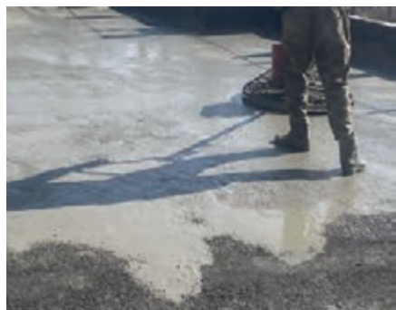
شکل ۵- تسطیح اسکرید با ماله پروانه‌ای
