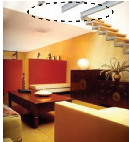
شکل ۱۱۳- ایجاد حفره درون سقف ۱ در فضا با حفظ تیرهای باربر سقف
