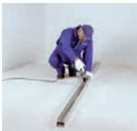
اجرای سازه سقفی دوتایی (در برخی ساختارها)
