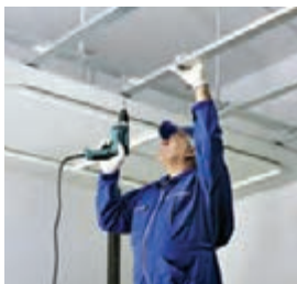
اتصال پانل به زیرسازی توسط ۷ پیچ (هر ۱۷ سانتی‌متر)
