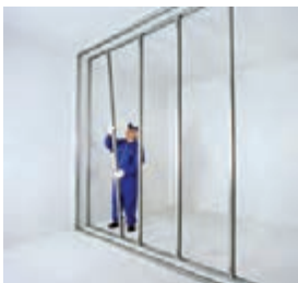
اجرای ردیف اول استاده‌ها
