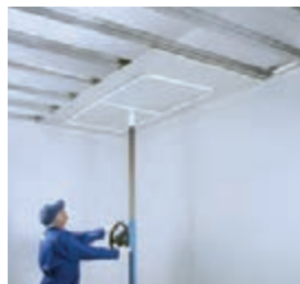
اسقرار پانل با استفاده از بالابر
