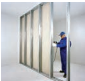
اجرای پانل‌ها در یک طرف دیوار
