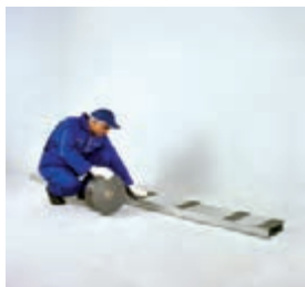
اجرای نوار عایق بر روی استاداها
