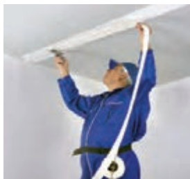
درزگیری و ماستیک توسط پودرهای مخصوص و نوار درزگیری
