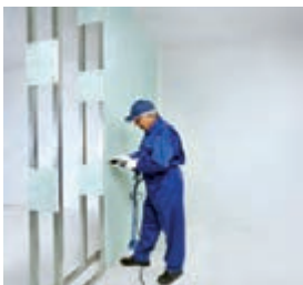
اجرای پانل‌ها در یک طرف دیوار اجرای عایق معدنی
