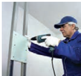
استاده‌های ردیف اول و دوم به وسیلهٔ برش‌هایی از پانل به یکدیگر وصل می‌شوند
