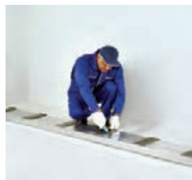
برش نوارهای عایق
