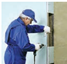
اجرای پانل‌ها در طرف دیگر دیوار
