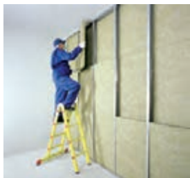
اجرای عایق پشم معدنی
