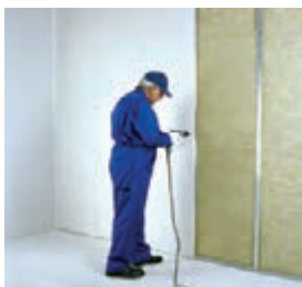
اجرای پانل‌ها در دو طرف دیوار
