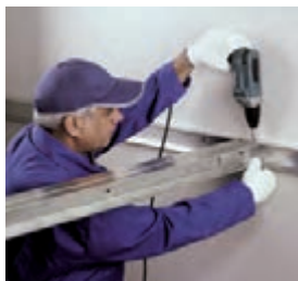
اتصال بال‌های فوقانی سازه سقفی به سازه تراز باربر
