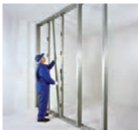
اجرای ردیف دوم استاداها
