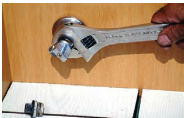
شکل ۳-۲۵۴- سفت کردن شیر پیسوار
