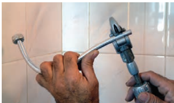
شکل ۲۲۲-۳- بریدن لوله‌ی پیسوار به وسیله‌ی لوله‌بر
