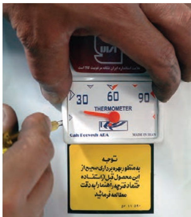
شکل ۱-۱۱۷ جدا کردن ترمومتر از روپوش
