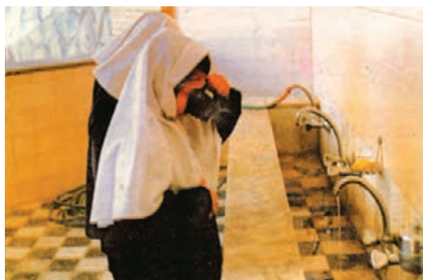
شکل ۲-۵۹- چکه کردن شیر آب
