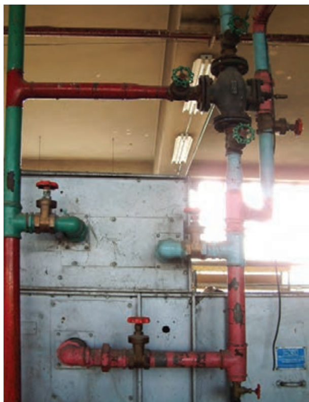
شکل ۲-۸۳ – مورد استفاده‌ی شیر فلکه در تهویه‌ی مطبوع
