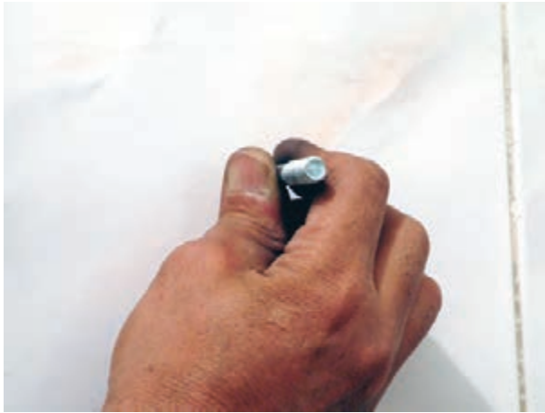
شکل ۴۳-۳ بستن پیچ‌ها در درون رولپلاک‌ها با دست
