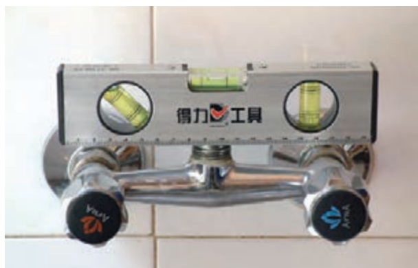
شکل ۱۷۴-۲ سنجش تراز بودن شیر مخلوط دیواری
