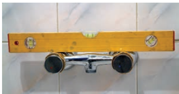
شکل ۲-۱۹۰- سنجش تراز بودن شیر مخلوط
