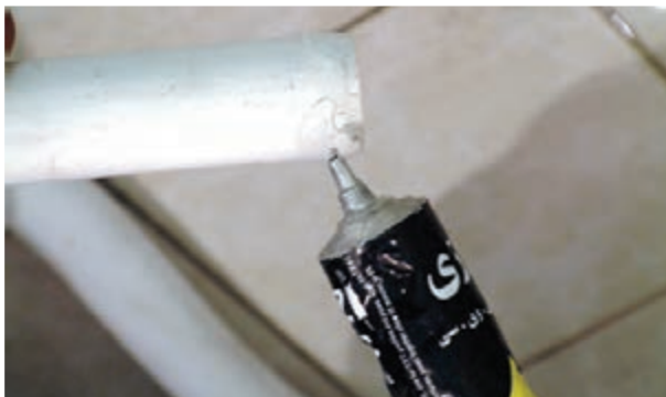
شکل ۳-۲۰۵- زدن چسب به لوله‌های تخلیه
