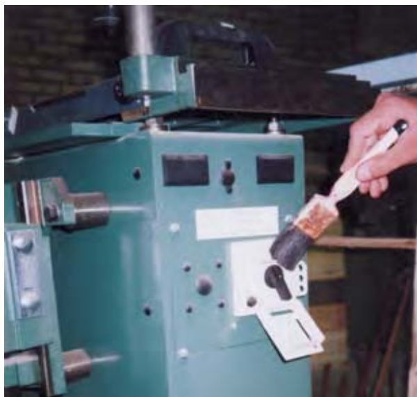
شکل ۱۰-۱۵- گردگیری و تمیز کردن کلید برق.
