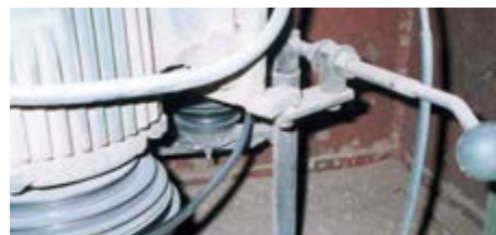
شکل ۳-۱۴. باز کردن درپوش (روی تسمه‌ها).
