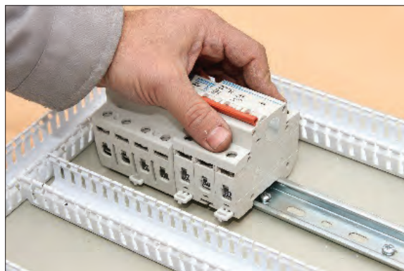
شکل ۴۶- نصب قطعات روی ریل
