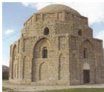
شکل ۱۰۶-۲- کرمان، گنبد جبلیه، سنگ لاشه و ملات
