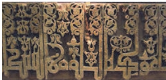
شکل ۶۱-۲- خراسان، آجر تراش، مدرسه غیاثیه خرگرد
