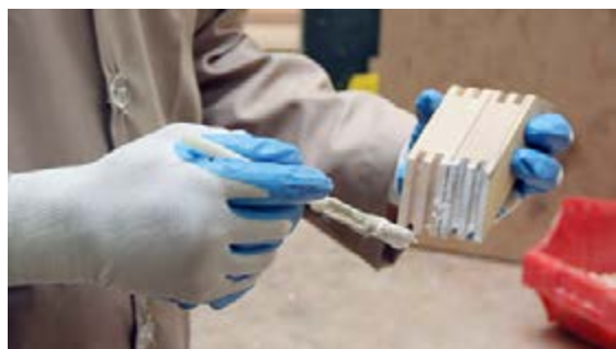
شکل ۱۰۸- چسب زدن نبشی‌ها
