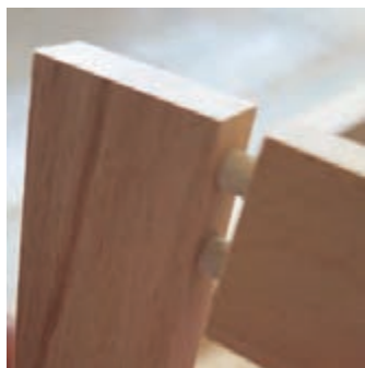
شکل ۱۱- اتصال دوبل (میخ چوبی)
