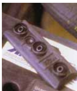
شکل ۳۶-۵- برداشتن درپوش خانه های باتری
