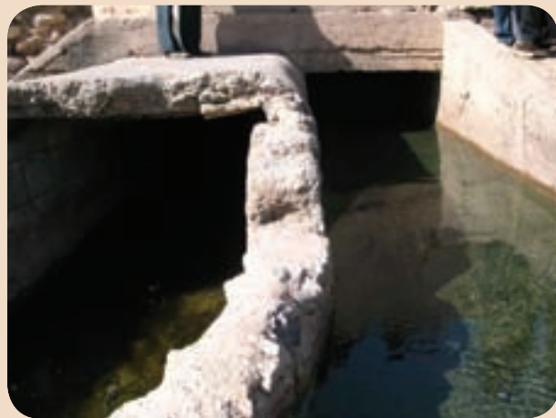
شکل ۱-۵۴- مظهر قنات بر آب پاکم درخواجه عسکر بم
