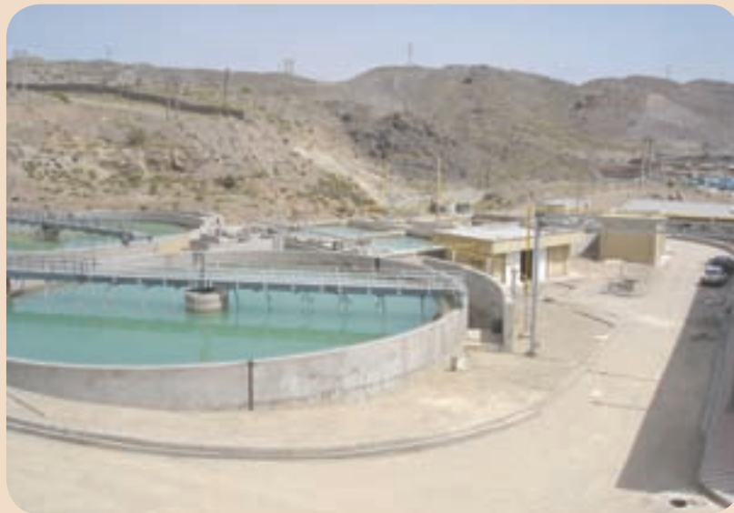
شکل ۵۹-۱- تصفیه خانه مجتمع مس سرچشمه
