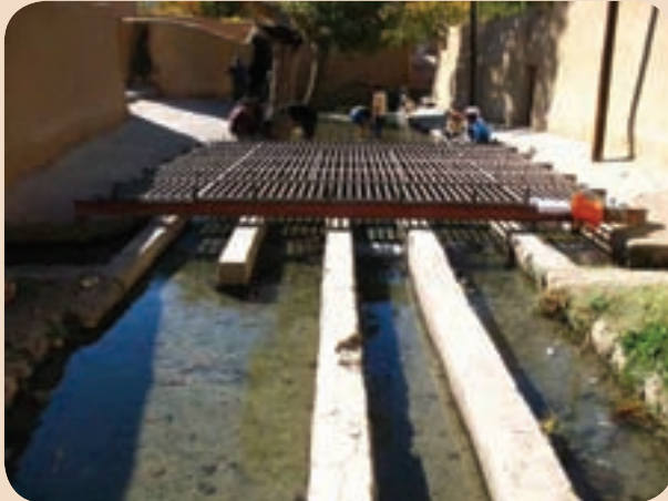
شکل ۱-۵۳- قنات گهر ریز جوپار (شش مقسم)
