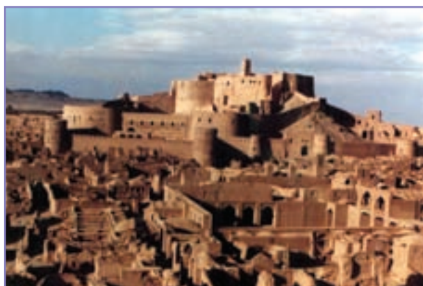
شکل ۳۱-۵- ارگ بم در حال بازسازی
