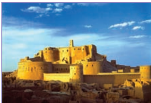
شکل ۳۰-۵- ارگ بم قبل از زلزله
