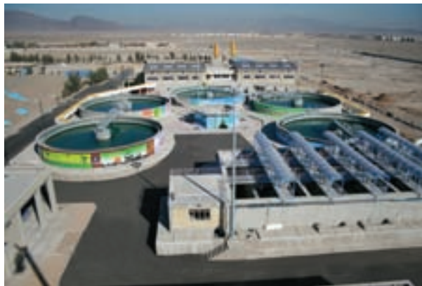
شکل ۱۲-۴ تصفیه خانه آب زاهدان
