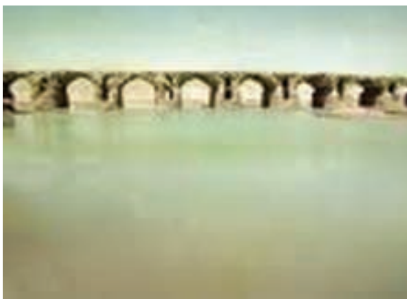
شکل ۱۱-۵- پل لاتیدان، ۵۰ کیلومتری غرب بندرعباس
