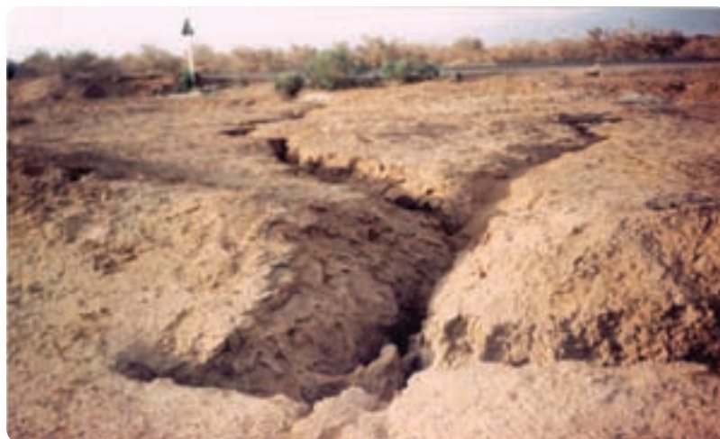
شکل ۱-۶۴- پدیده فرونشست در منطقه رضوان شهر
