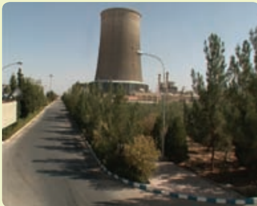
شکل ۱۰-۶ نیروگاه سیکل ترکیبی
