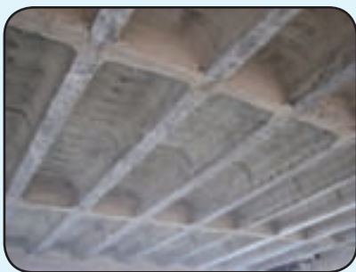
ب) برداشتن فوم بعد از بتن ریزی
