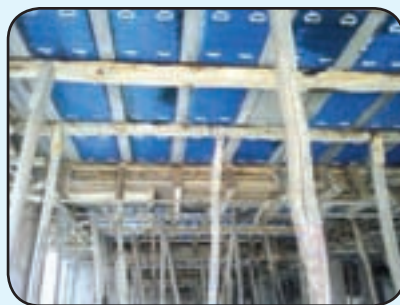
الف) استفاده از فوم قبل از بتن ریزی
