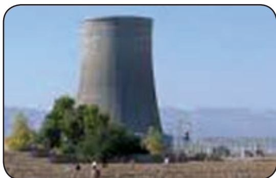
نیروگاه سیکل ترکیبی (کازرون)
