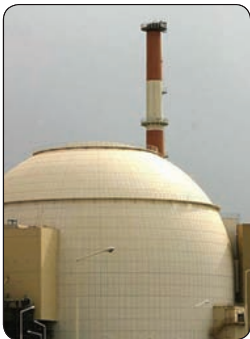
نیروگاه اتمی بوشهر
