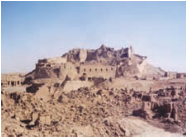
(ب) ارگ بم بعد از زلزله
