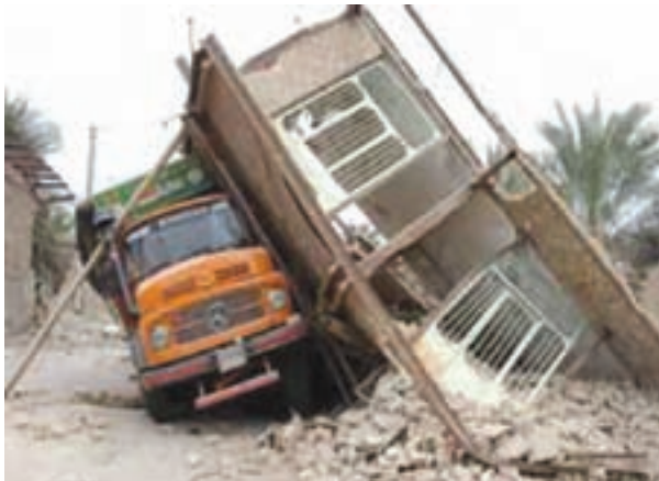
(د) ریزش دیوار در اثر زلزله
