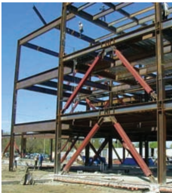
شکل ۵۰-۳- مقاوم سازی ساختمان‌ها در مقابل زمین لرزه
