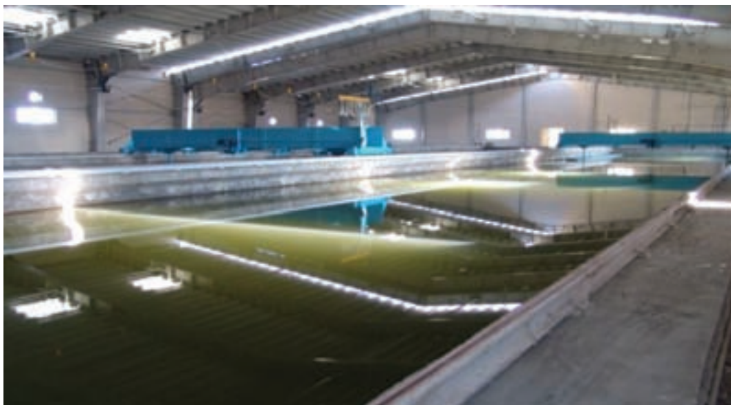
شکل ۴۵-۱- تصفیه خانه آب مشکین شهر
