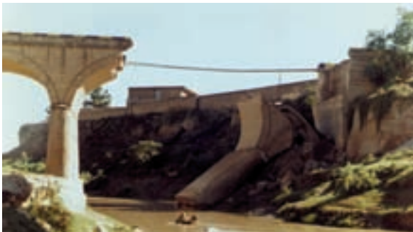
شکل ۱۷-۶- تخریب یک پل ارتباطی بر اثر سیل
