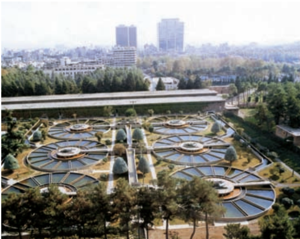
شکل ۱۴-۹- تصفیه‌خانه‌ی شماره‌ی ۲ آب تهران - جلالیه
