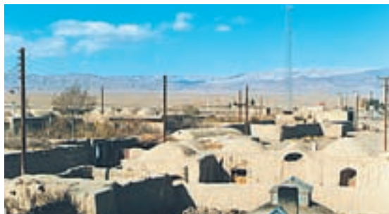
شکل ۴۱-۲ سقف خانه‌ها در مناطق گرم - سمنان
