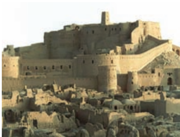
(الف) ارگ بم قبل از وقوع زلزله
