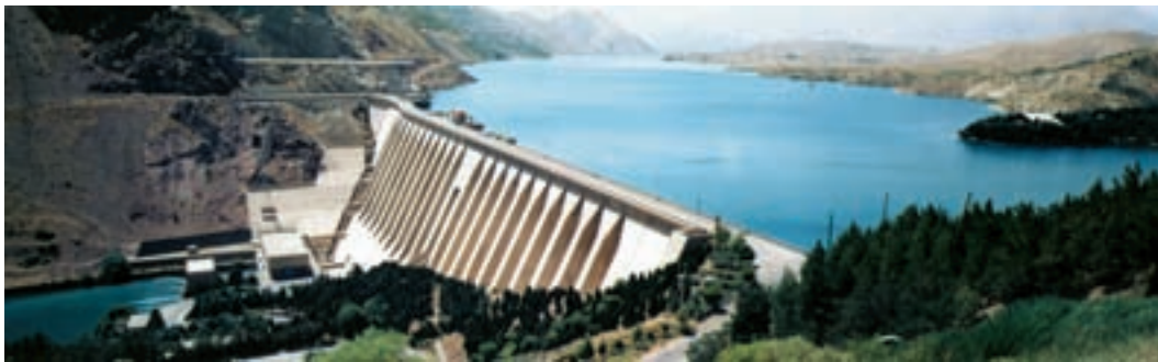
شکل ۲۸-۶- احداث سد روشی برای کاهش خطر خشک‌سالی
