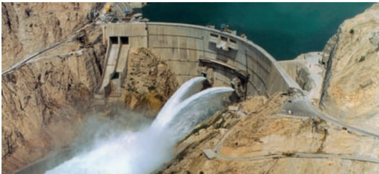
شکل ۲- سد کارون ۳، خوزستان
