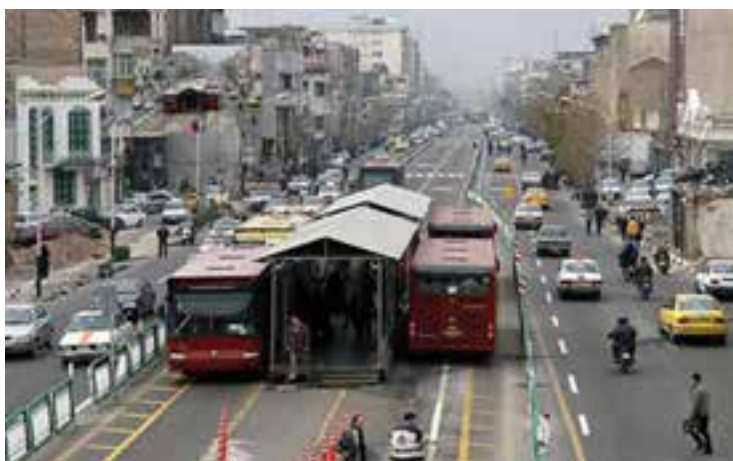
شکل ۲۹-۱- ایستگاه اتوبوس‌های تندرو (BRT)
