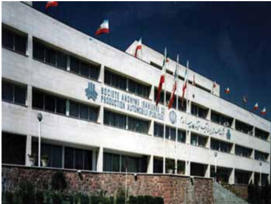
شکل ۲۵-۵- شرکت خودروسازی سایپا
