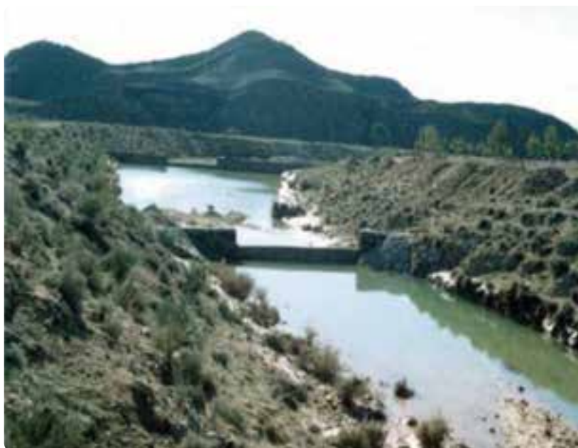
شکل ۳۲-۱- حفاظت خاک و کنترل رسوب در اطراف سد سلمان فارسی
