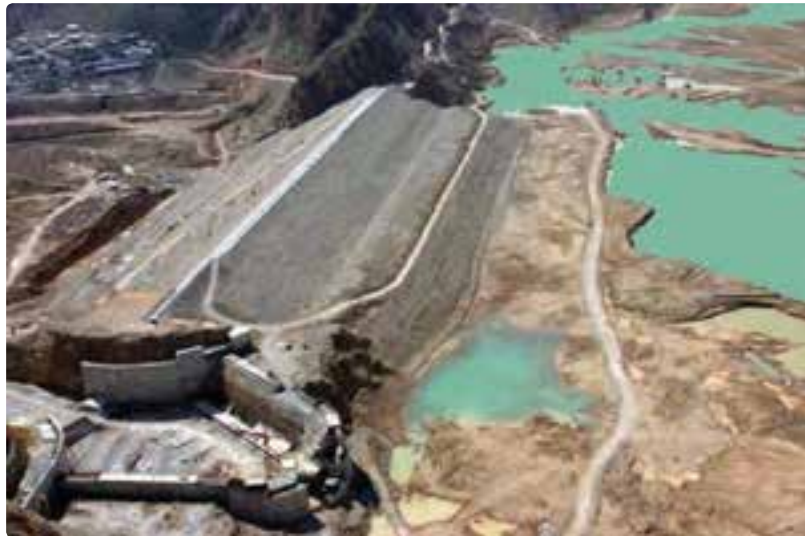
شکل ۱-۲۶- احداث سد سیوند بر روی رود سیوند
