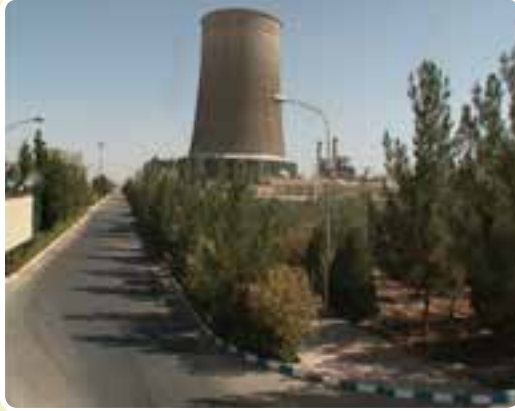
شکل ۱۰-۶- نیروگاه سیکل ترکیبی
