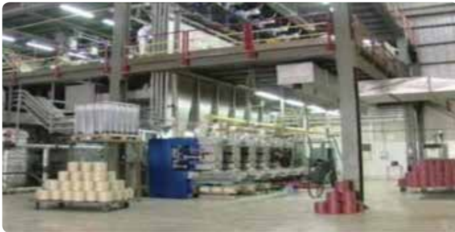
شکل ۱۵-۶- کارخانه کابل نوری یزد
