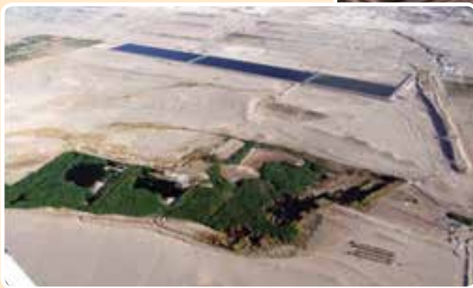
شکل ۳۸-۱- تصویر هوایی برکه‌های تصفیه خانه فاضلاب شهر یزد
