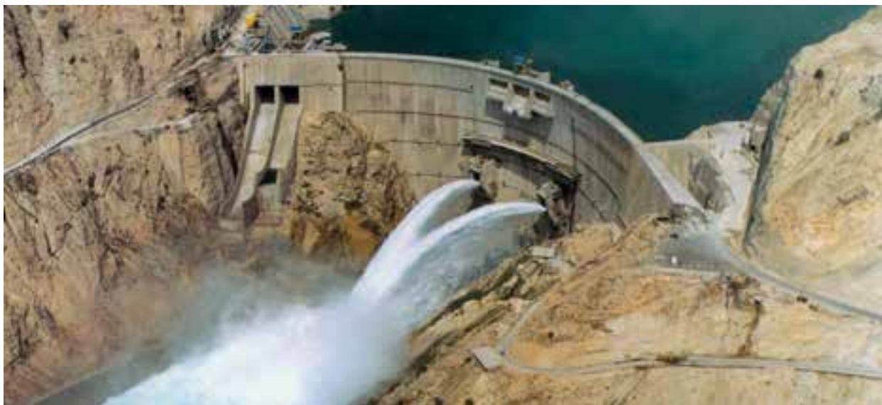
شکل ۲- سد کارون ۳، خوزستان
