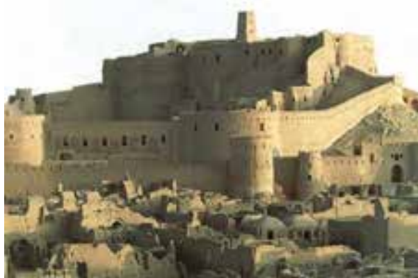
الف- ارگ بم قبل از وقوع زلزله
