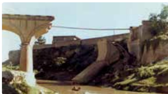
شکل ۱۵-۶- تخریب یک پل ارتباطی بر اثر سیل
