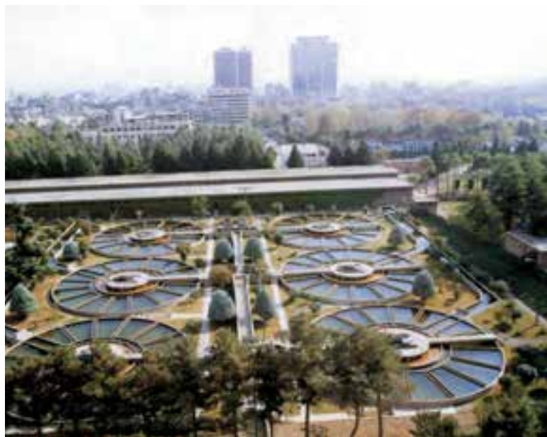
شکل ۱۲-۹- تصفیه‌خانه شماره ۲ آب تهران - جلالیه
