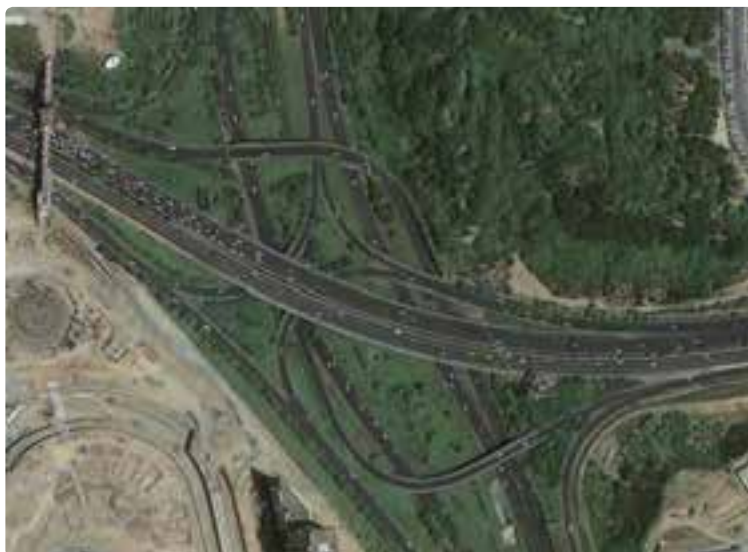
شکل ۱۴-۱- عکس هوایی از پل فجر تهران (تقاطع بزرگراه‌های مدرس و همت)
