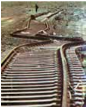
شکل ۶-۶- تخریب خط آهن بر اثر وقوع زلزله
