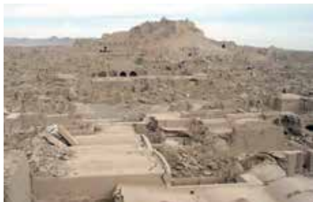
ب- ارگ بم بعد از وقوع زلزله
