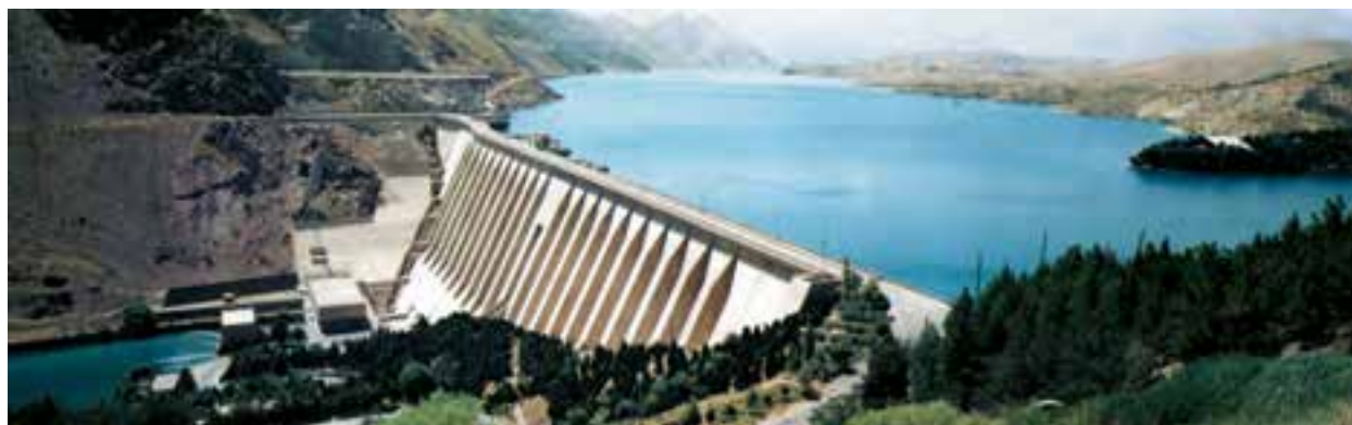
شکل ۲۶-۶- احداث سد روشی برای کاهش خطر خشک‌سالی
