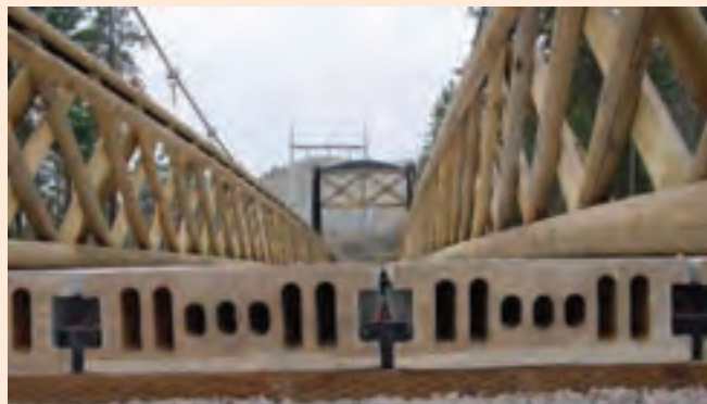
شکل ۱۱-۱۲- استفاده از چوب پلاستیک در کف پوش پل
