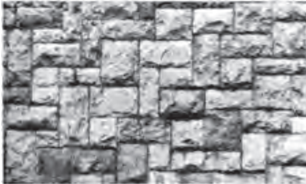
شکل ۹-۴- استفاده از سنگ بادر در نما
