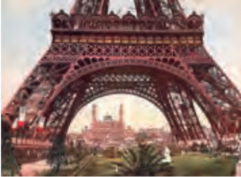
شکل ۲-۱۰- برج ایفل در حال ساخت - پاریس ۱۸۸۹ میلادی
