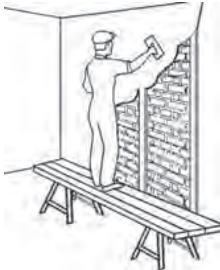
شکل ۵-۸- طریقه‌ی گچ کاری دیوار
