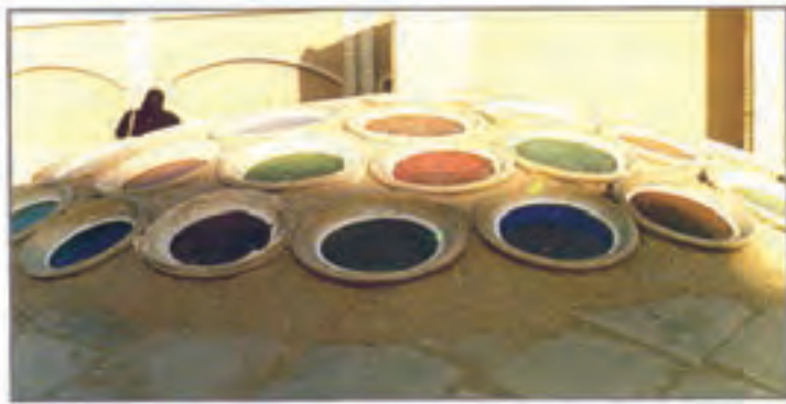
شکل ۲-۱۲- استفاده از گلجام در بازسازی سقف حمام
