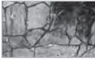
شکل ۷-۴- استفاده از سنگ لاشه
