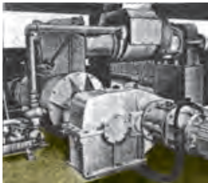
(الف) تجهیزات مختلف در یک دستگاه پاگمیل هوازدا
