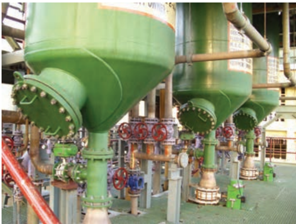
شکل ۴-۳- بخشی از کارخانه کلر آلکالی
