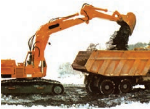
شکل ۲۳-۴- کج بیل در حال حفر کانال
