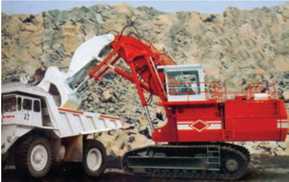
شکل ۱۹-۴- بیل مکانیکی در حال بارگیری
