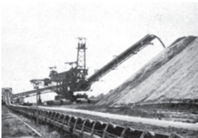
شکل ۳۱-۲ جابه‌جایی باطله توسط نوار نقاله
