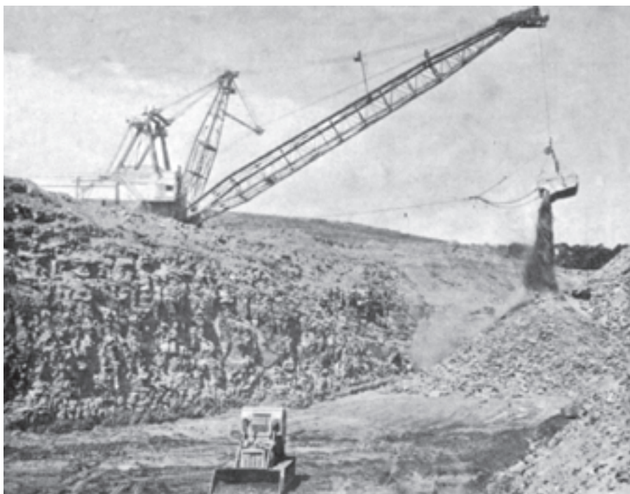
شکل ۲۷-۴- دراگلین در حال کار
